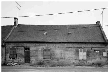
Logis. Elévation sur rue. Phot. Jean-Michel Perrin IVR22_19856000748X
