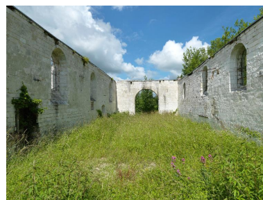
Vue intérieure de l'ancienne église incendiée en 1991. Phot. Thierry Lefebure IVR22_20128000322NUCA
