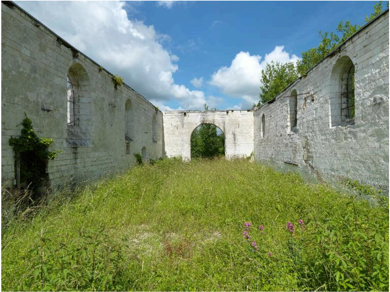
Vue intérieure de l'ancienne église incendiée en 1991.
