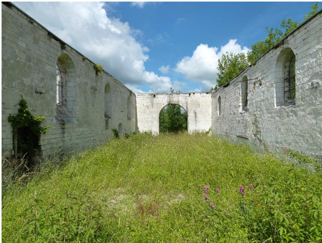
Vue intérieure de l'ancienne église incendiée en 1991.
