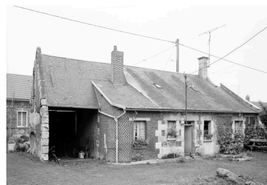
Logis. Elévation postérieure. Phot. Jean-Michel Perrin IVR22_19846000995X
