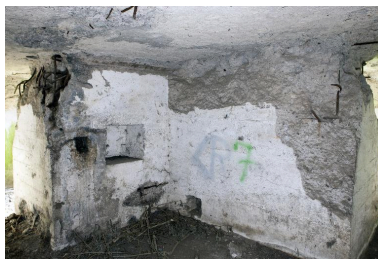
Couloirs en chicane de l'entrée est, à gauche et ouest à droite Phot. Pierre Thibaut IVR31_20155901719NUCA
