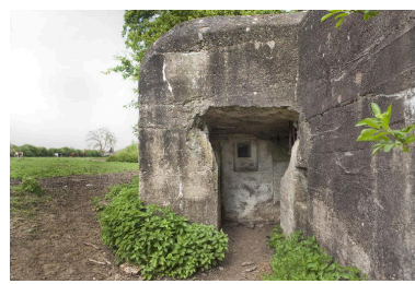
Entrée ouest Phot. Jean-Marc Ramette IVR31_20145904020NUCA
