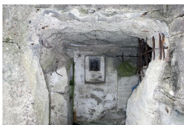
Couloir en chicane de l'entrée ouest, vers l'intérieur. Phot. Pierre Thibaut IVR31_20155901716NUCA
