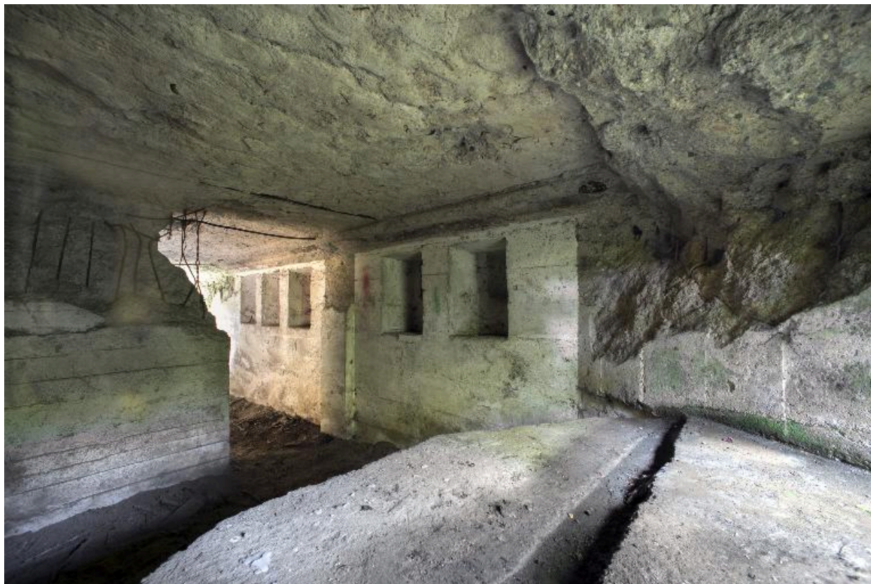
Au premier plan, la table de tir. A droite, les créneaux de fusillade orientés vers l'ouest
