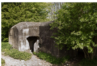
Entrée ouest Phot. Jean-Marc Ramette IVR31_20145904009NUCA
