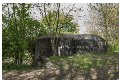
Vue générale, vers l'ouest Phot. Jean-Marc Ramette IVR31_20145904010NUCA
