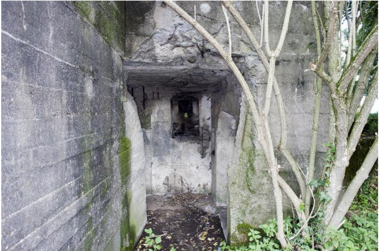
Couloir en chicane de l'entrée est, vers l'intérieur.
