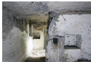
Couloir en chicane de l'entrée est, vers l'extérieur. Phot. Pierre Thibaut IVR31_20155901720NUCA
