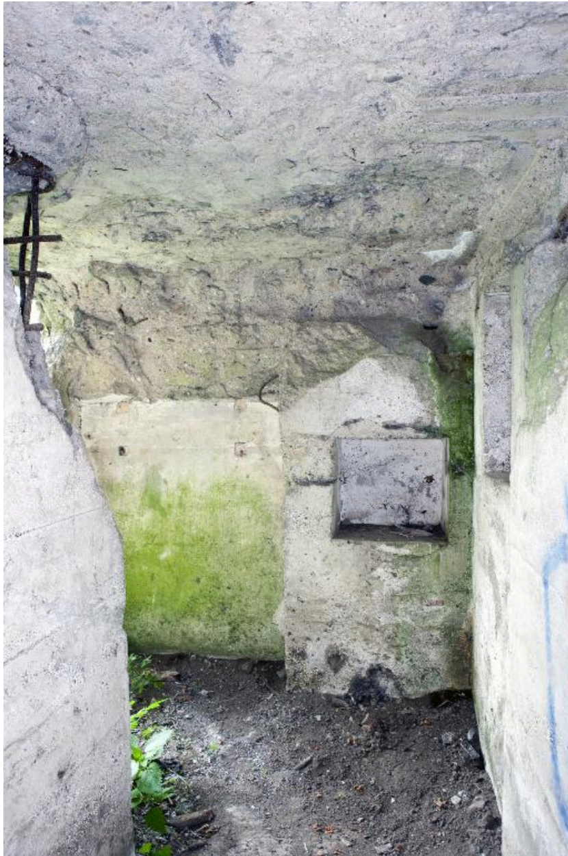
Couloir en chicane de l'entrée ouest, vers l'extérieur.
