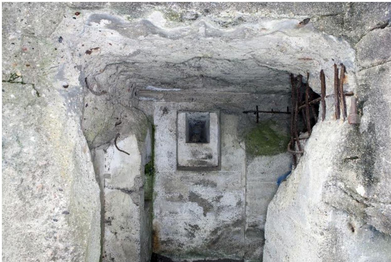
Couloir en chicane de l'entrée ouest, vers l'intérieur.
