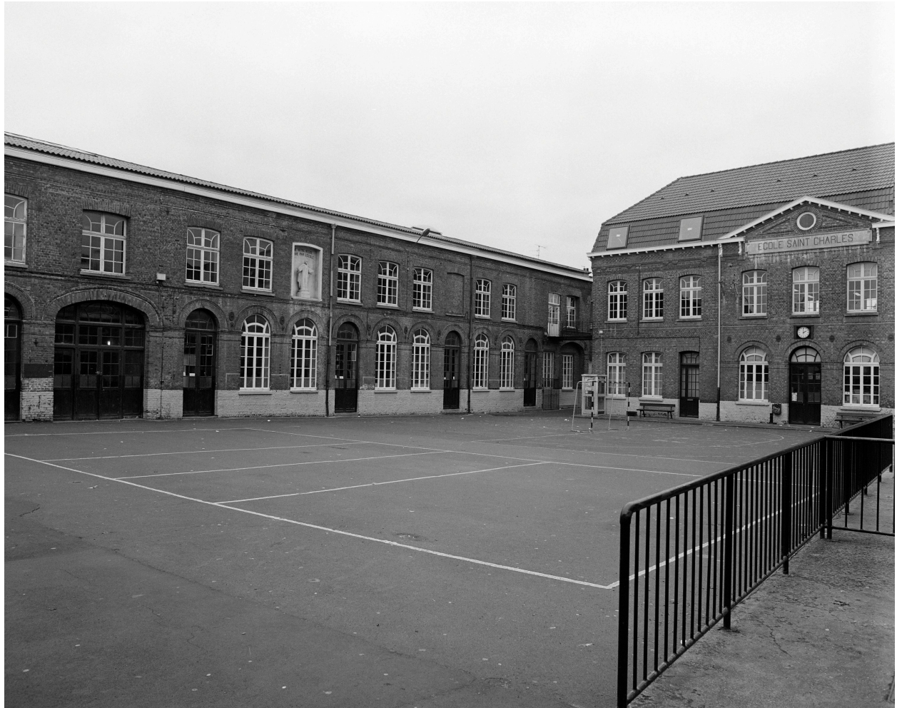
Atelier de fabrication. Vue prise vers l'ouest.
