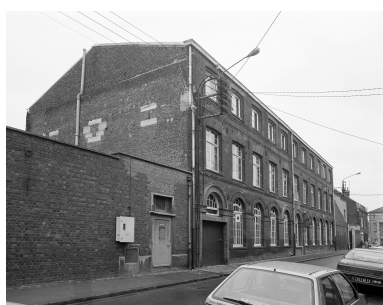
Élévation rue du Molinel. Phot. Philippe Dapvril IVR31_19885902343X
