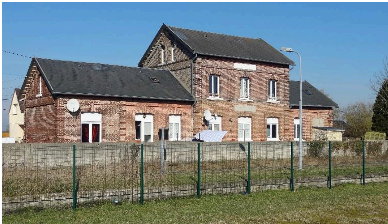
Vue générale de la façade sur voie.
