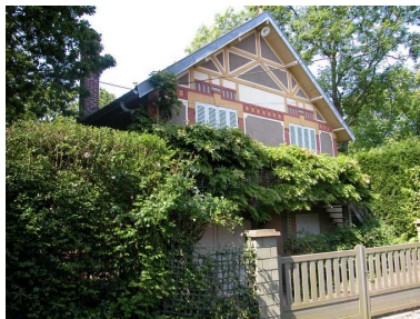
Vue d'ensemble depuis la rue.
