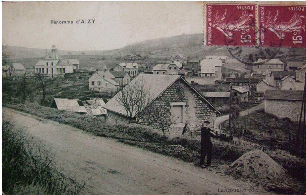
Vue du village en reconstruction (coll. part).
