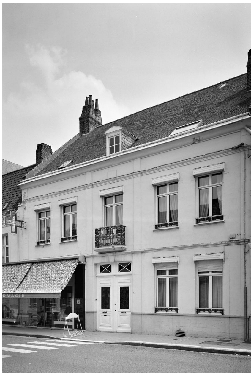
Vue générale depuis la rue de Saint-Omer.
