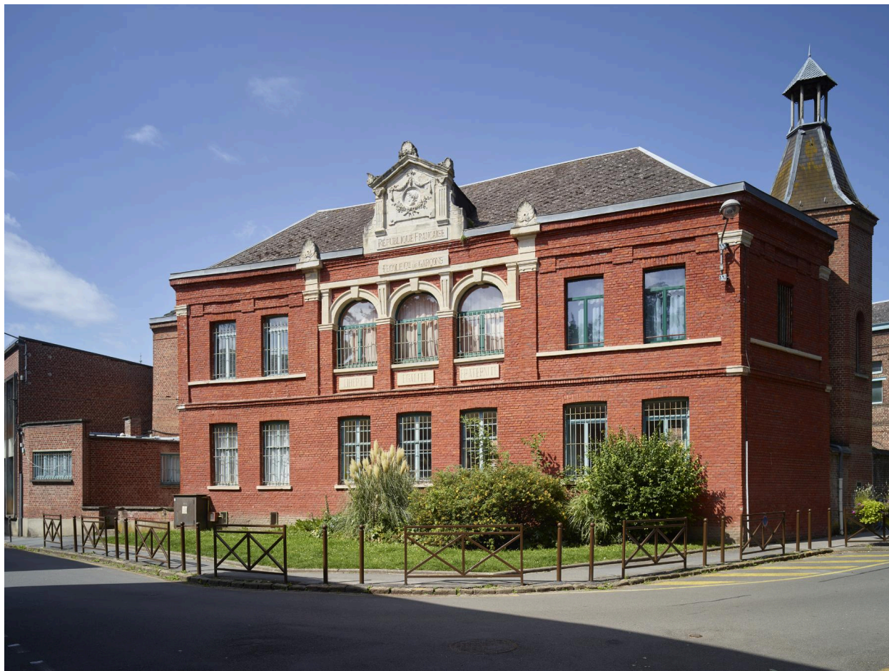
École de garçons, exemple représentatif d'architecture scolaire de la III ème République. Façade principale, rue Chevray.
