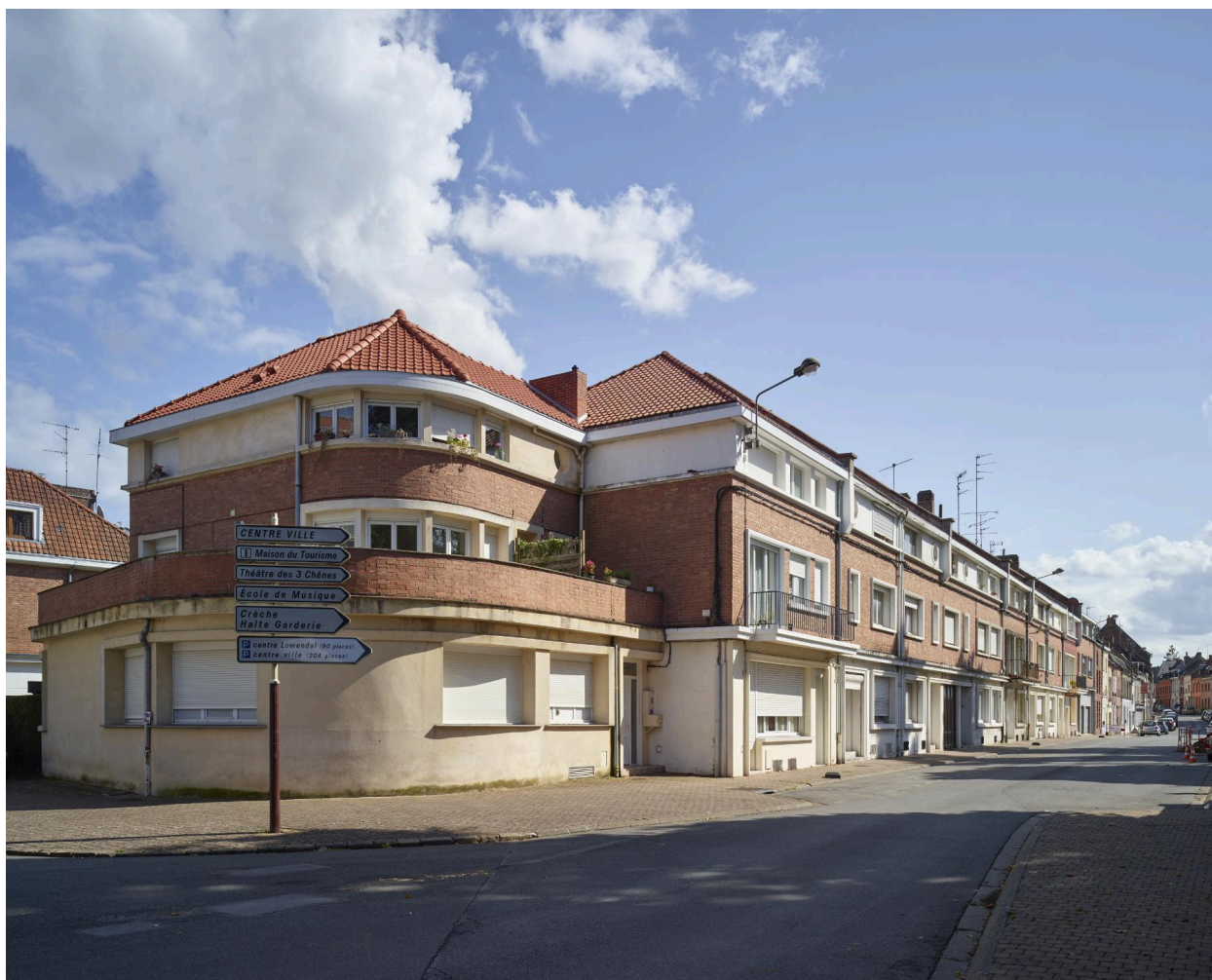
Immeubles à logement typiques de la Seconde Reconstruction, 44-60 rue Tanis. Vue orientée nord/sud.
