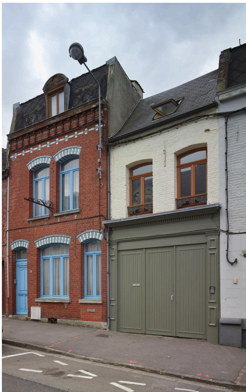
Maison typique de l'architecture privée de la fin du XIXe siècle avec son décor de briques émaillées, 31 rue Thiers.
