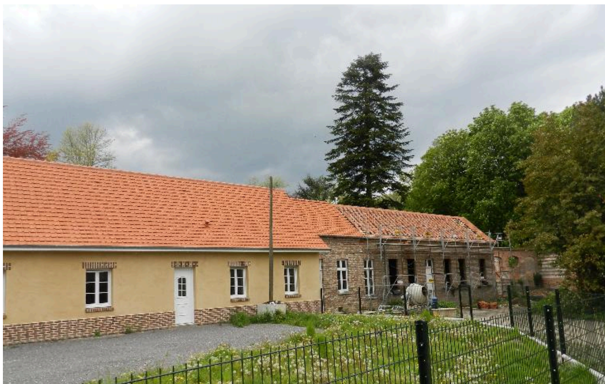
Vue de situation à refaire
