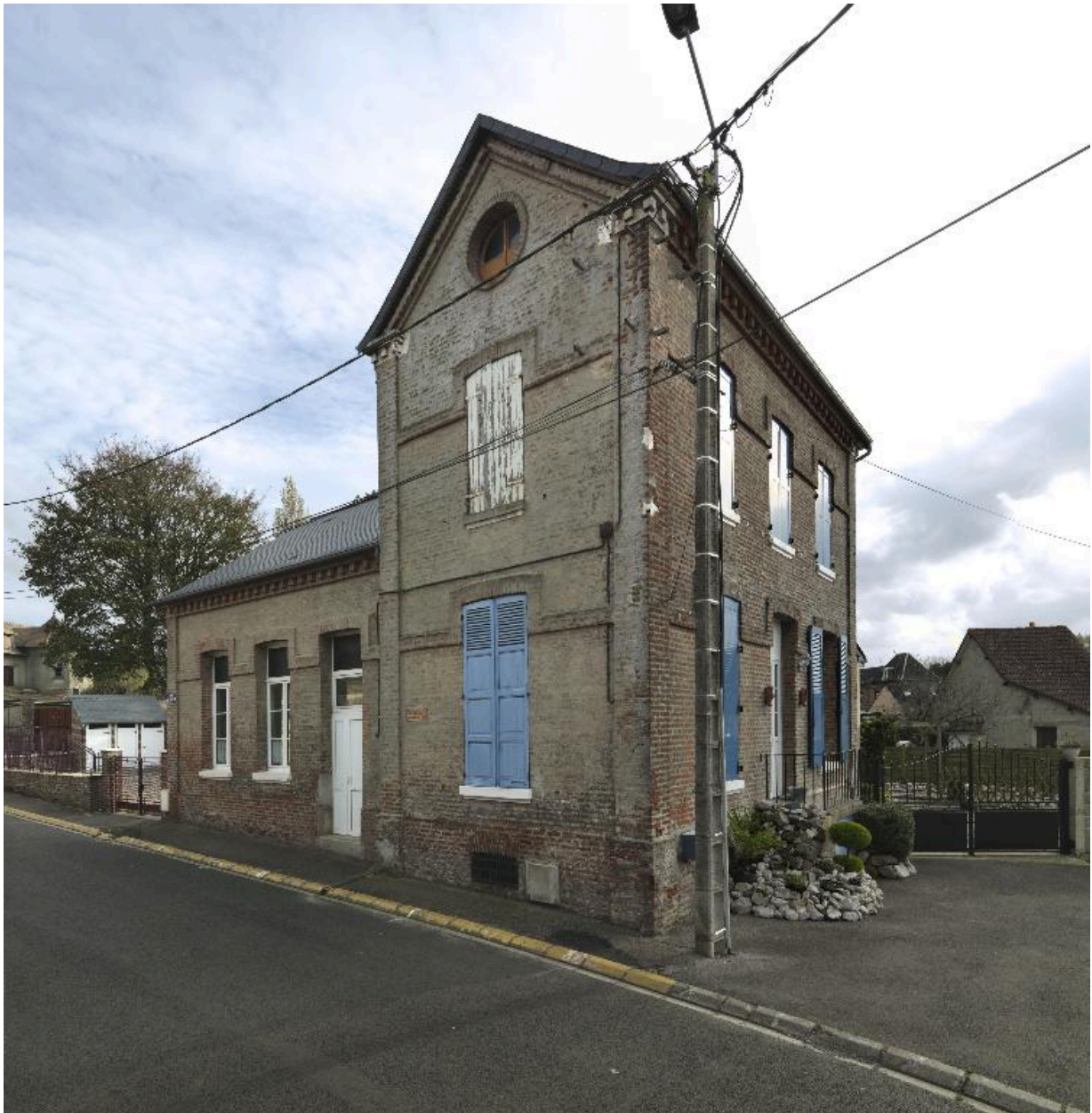
Vue générale depuis la rue des écoliers.
