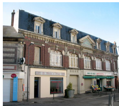
Vue générale de la succursale du Beauvaisis. Phot. Clarisse Lorieux IVR22_20076005558NUCAB
