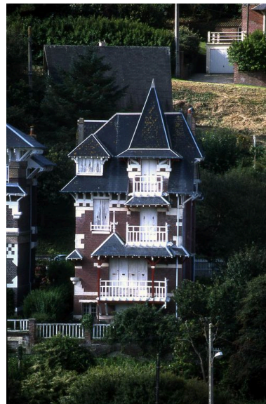
Elévation côté mer. Phot. Marie-Laure Monnehay-Vulliet IVR22_20048000182ZA
