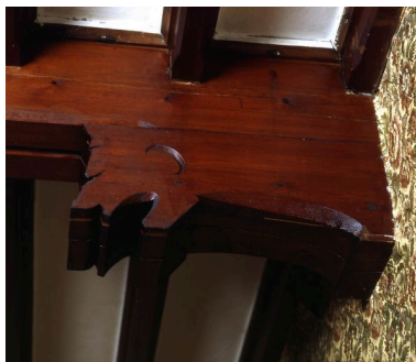
Détail d'une console du 'hall' figurant un animal. Phot. Marie-Laure Monnehay-Vulliet IVR22_20058001703XA
