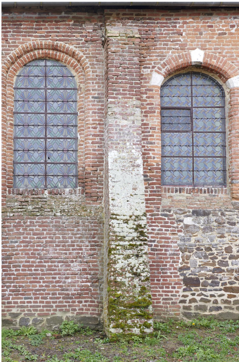
Vue de la jonction architecturale entre deux périodes de construction, à droite période originelle (Moyen Âge), à gauche élévation plus tardive (XVIIe s.).
