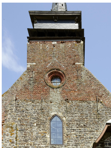
Détail de la façade occidentale de l'église, les élévations en grès
