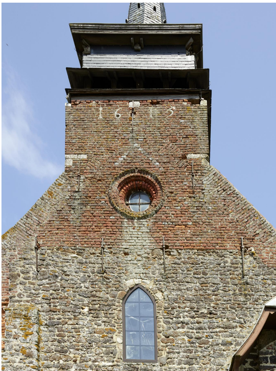
Détail de la façade occidentale de l'église, les élévations en grès datent de la construction originelle, la partie en brique date de 1615.
