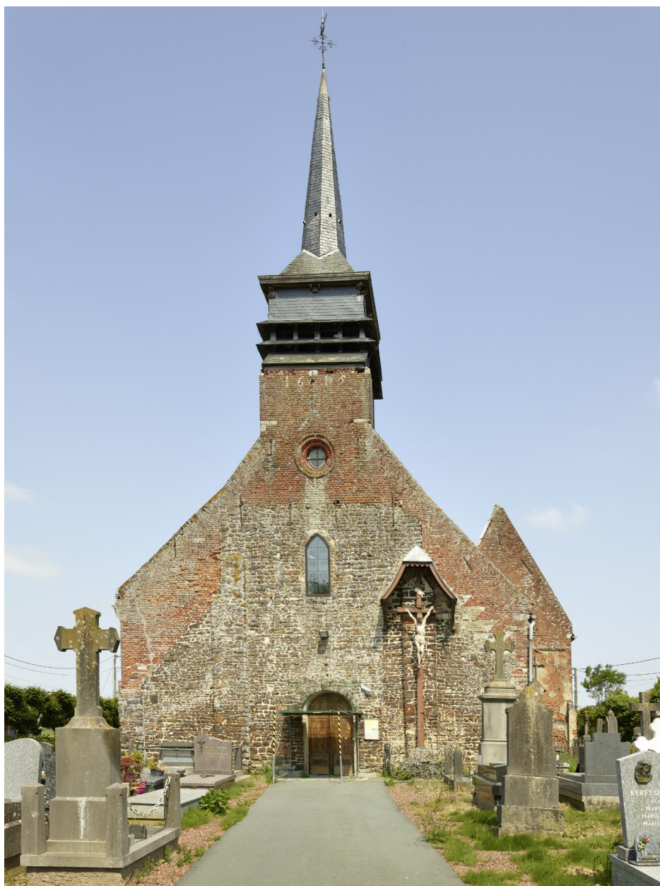
Façade occidentale de l'église.
