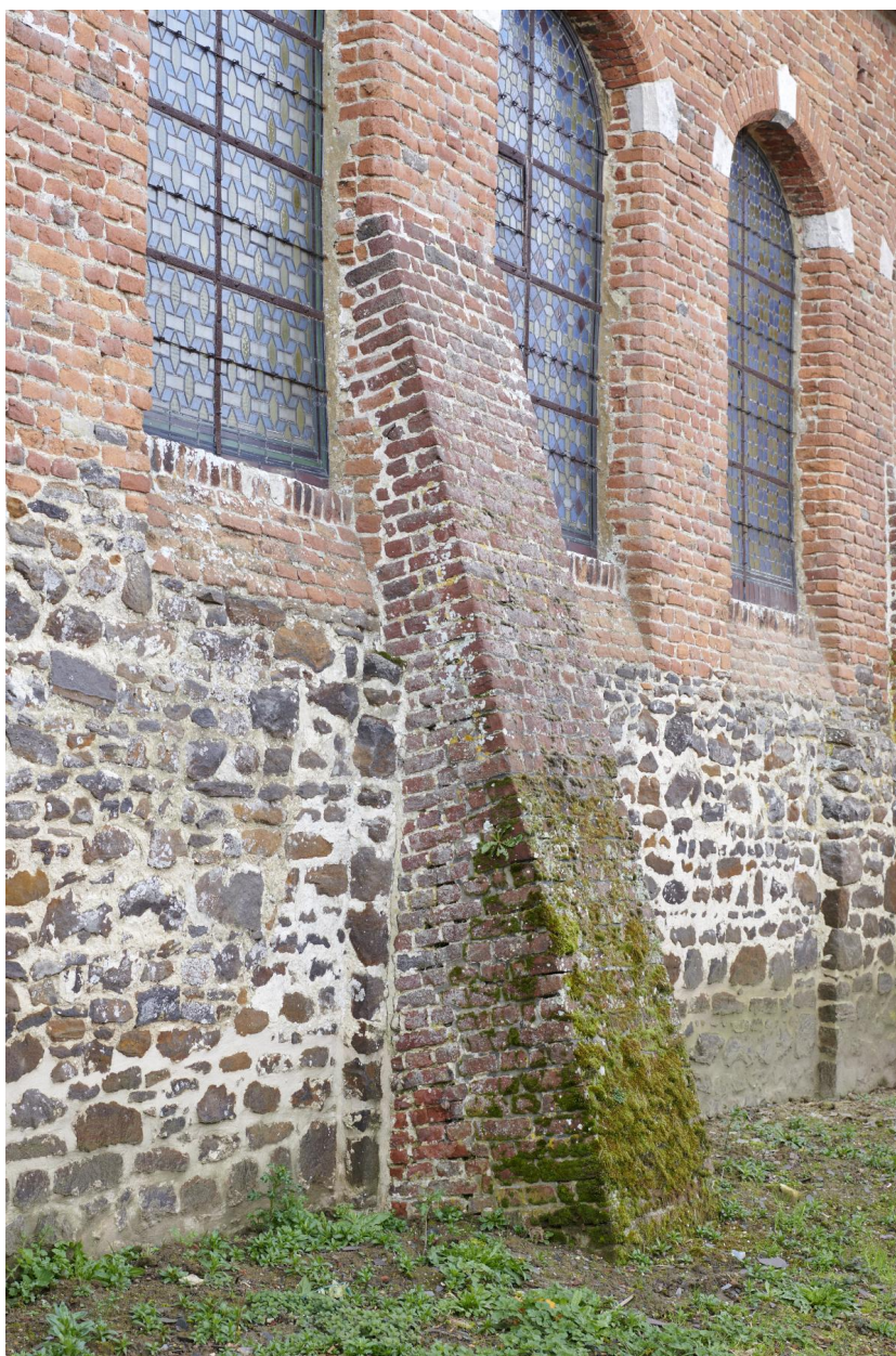
Détail de l'un des contreforts, renforcé aux périodes récentes (côté nord).
