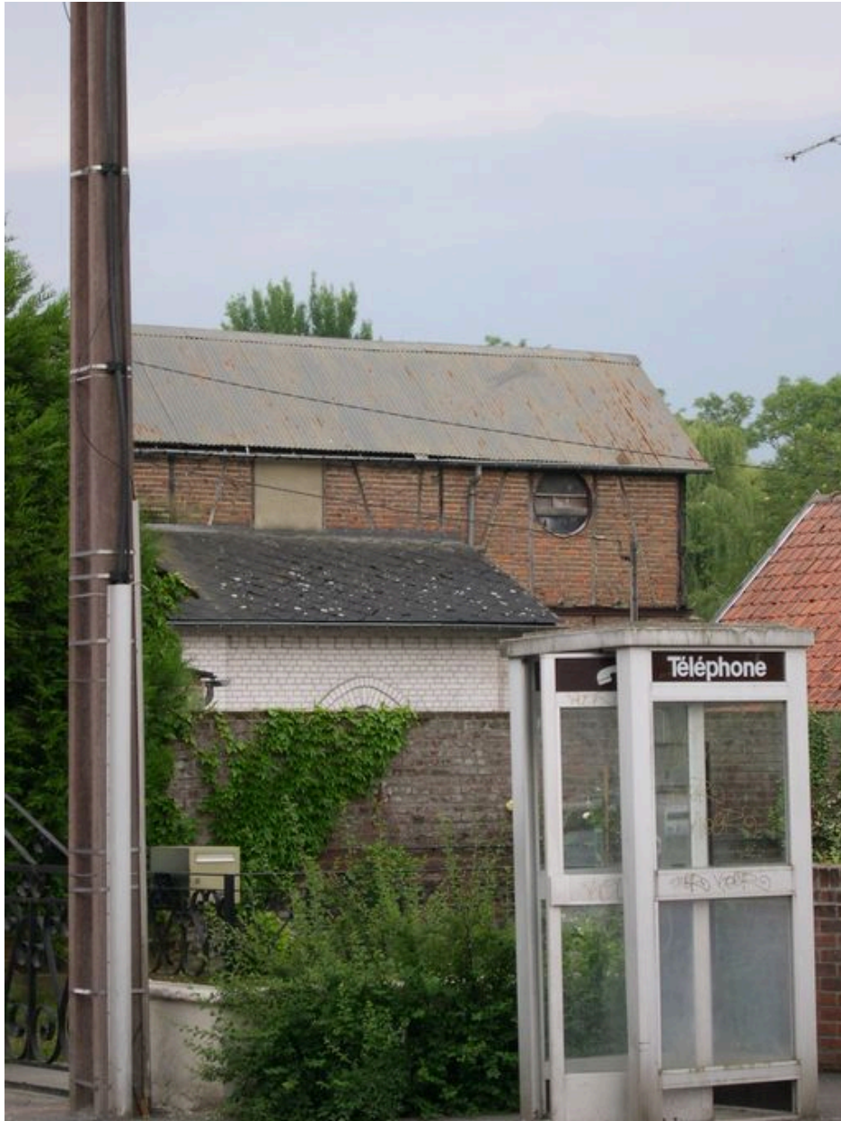
Détail sur le mur nord de la chapelle.
