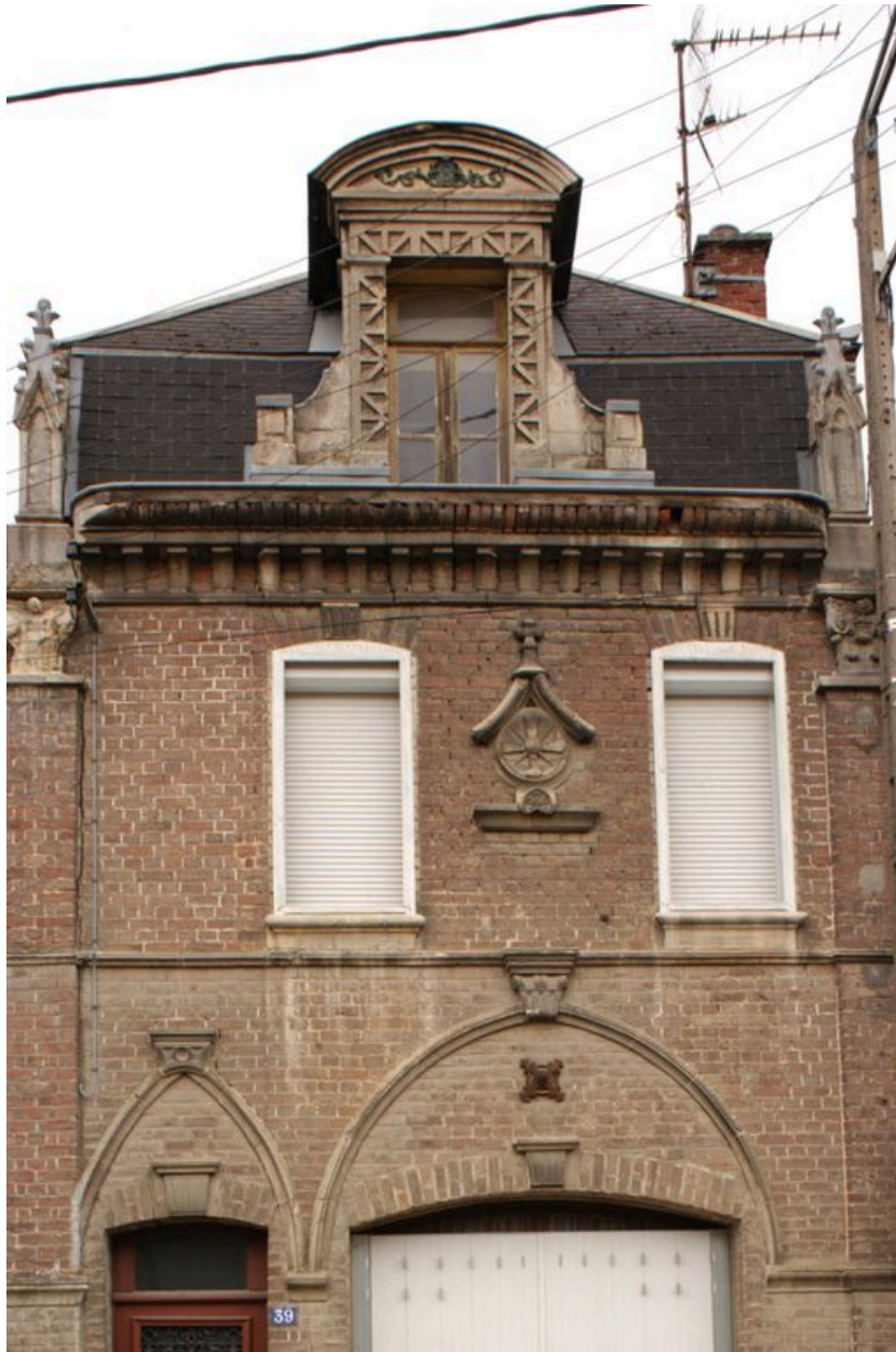
Détail sur la partie supérieure de la maison.
