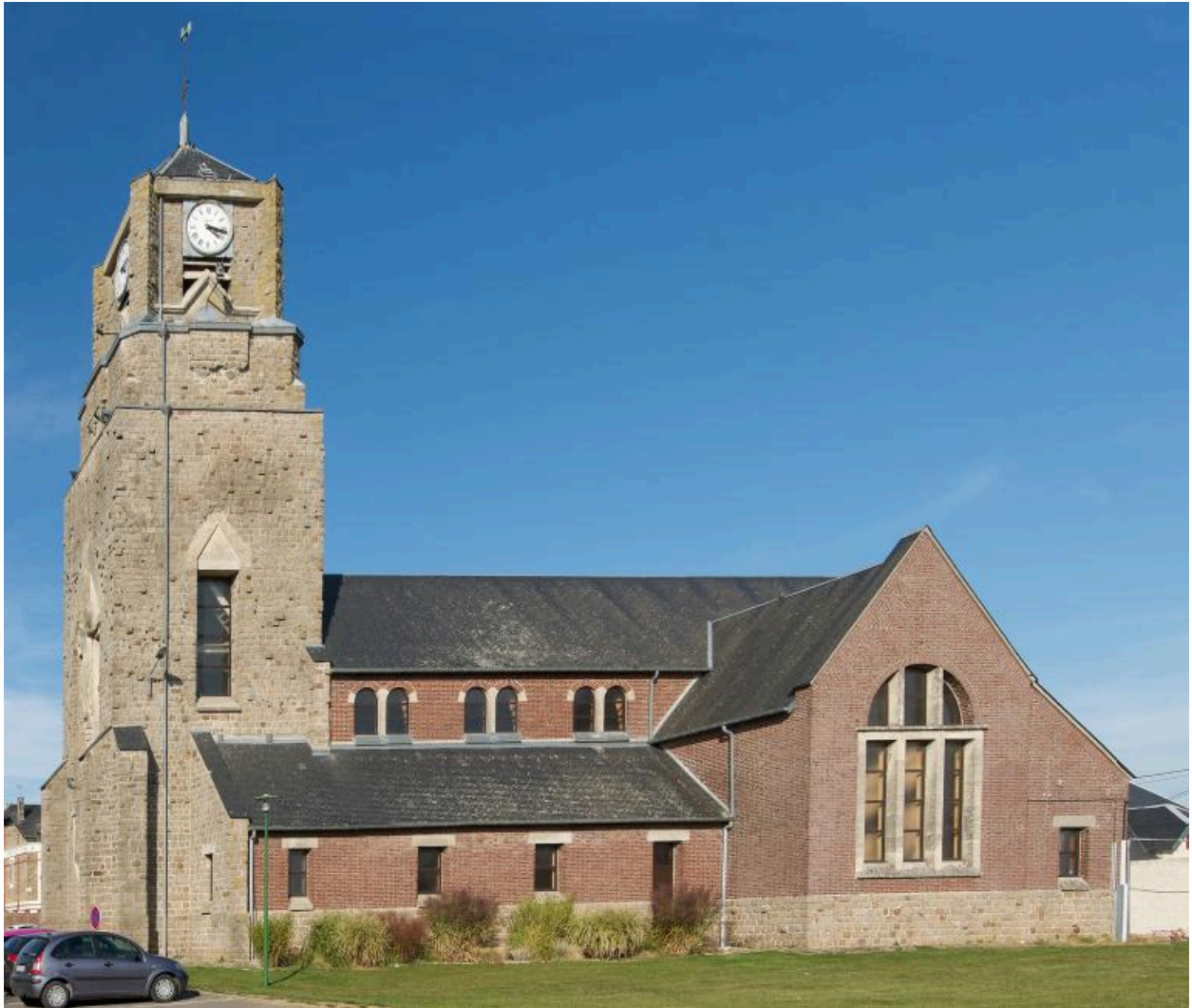
Façade latérale sud.
