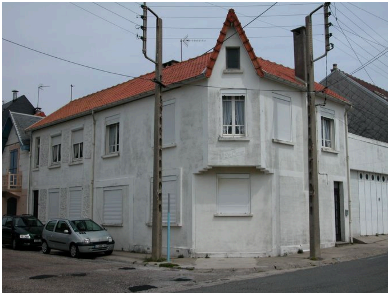
Vue d'ensemble depuis le carrefour rue des Dunes et de Paris, avec la maison dite Lou Contou au premier plan.
