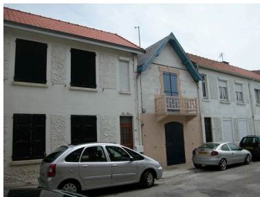
Maisons dite Les Lotus et L'Anémone, séparées par la maison (sans appellation) à pignon sur rue. Phot. Elisabeth Justome IVR22_20058002941NUCA
