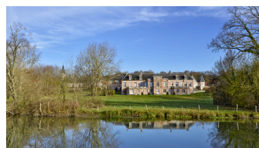
Vue de la façade sud du château, depuis le chemin de halage. Phot. Thierry Lefébure IVR32_20258000010NUCA
