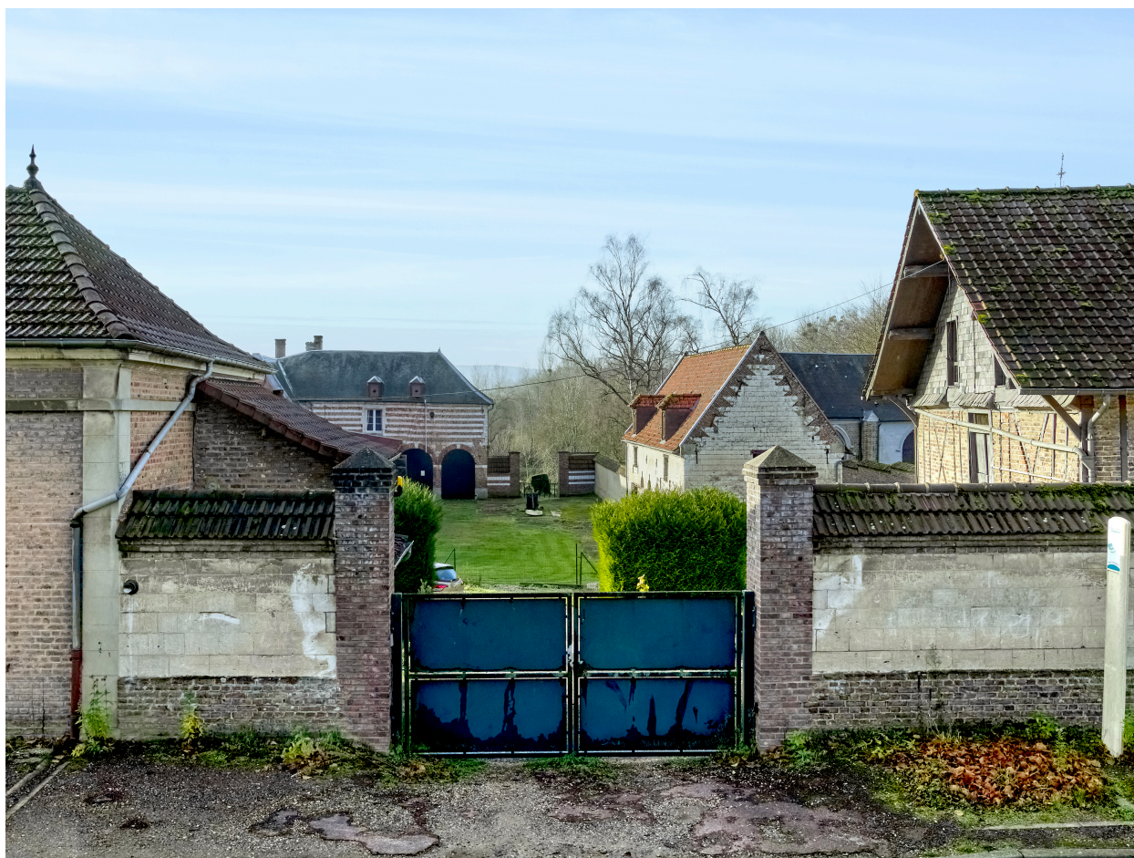
Vue de la ferme du château, depuis le nord.
