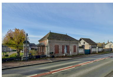
Vue de la maison du concierge, depuis le nord. Phot. Thierry Lefébure IVR32_20258000004NUCA
