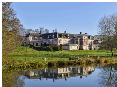
Vue du château, depuis le sud-ouest. Phot. Thierry Lefébure IVR32_20258000015NUCA
