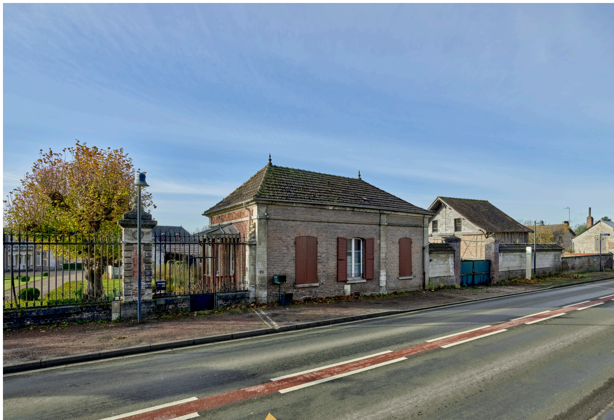
Vue de la maison du concierge, depuis le nord.
