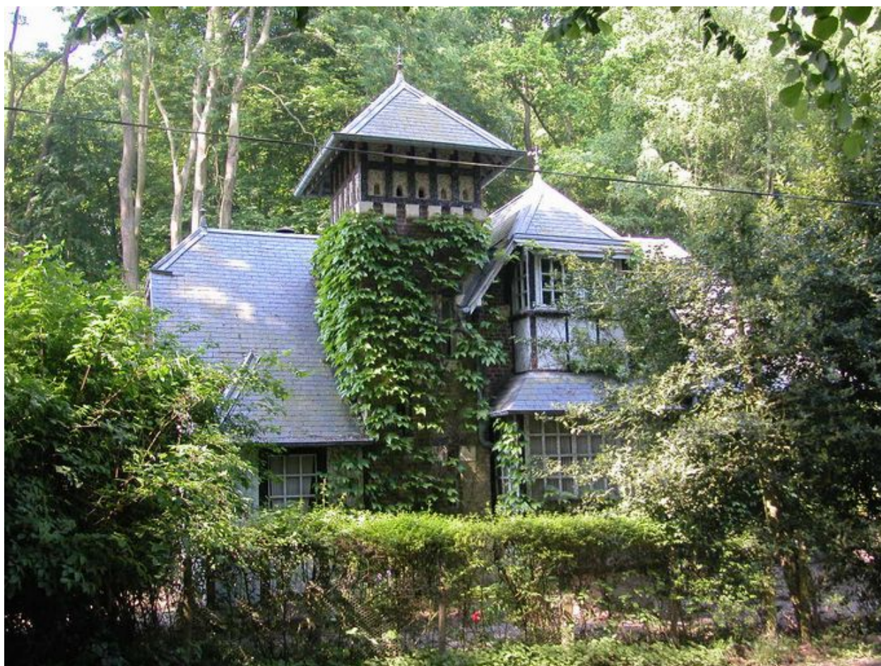
Vue d'ensemble depuis la route du Vieux-Chêne.
