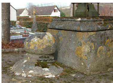
Le socle de pierre de la croix à l'arrière duquel est placé un ancien socle (?) de croix. Phot. Frédéric Fournis IVR22_20108001131NUCA
