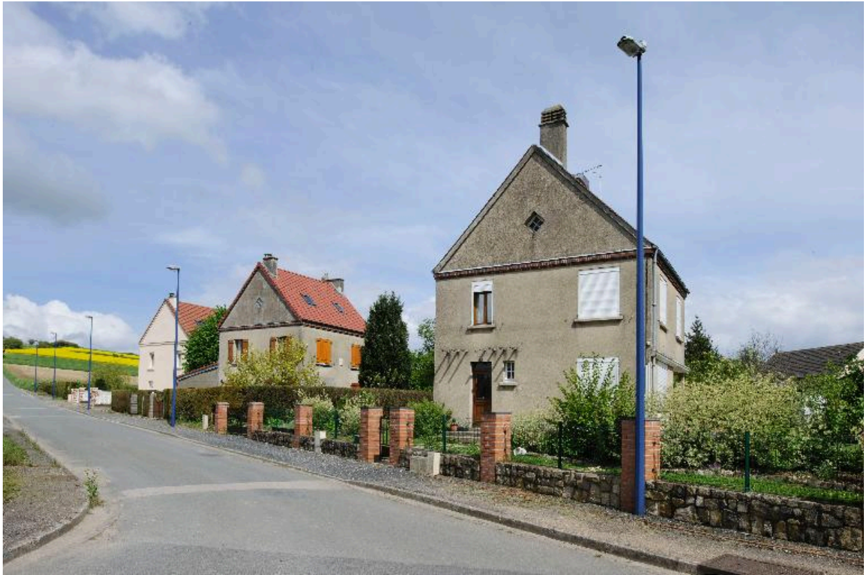
Vue d'ensemble des trois logements du chemin de Huleux.
