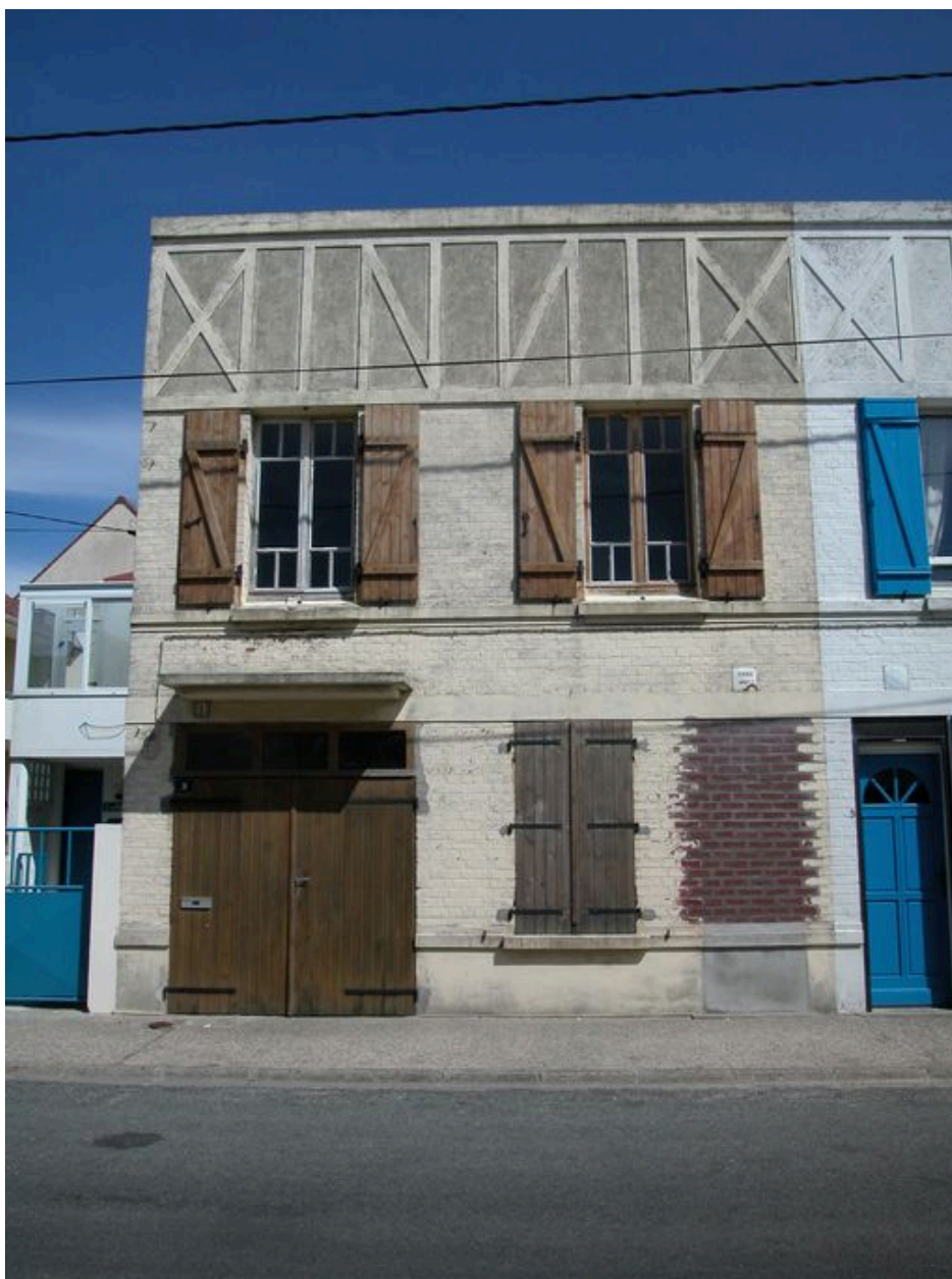
Logement dit Chez Nous (XA 190).
