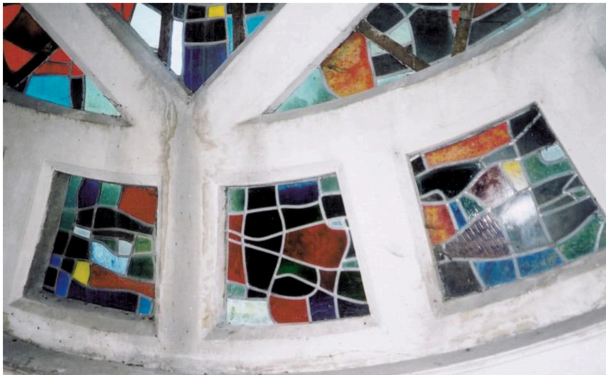
Détail de la rose de la façade principale, par Lardeur.
