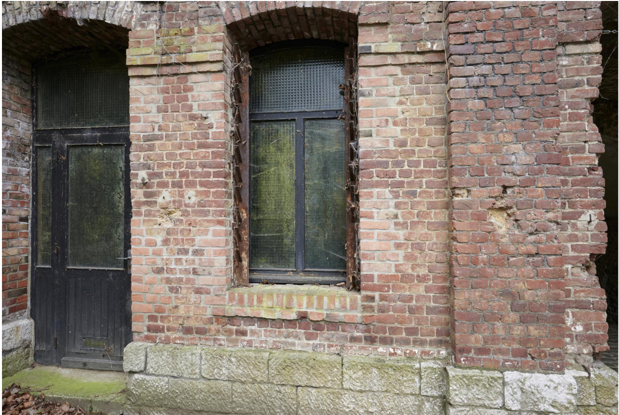
Cuisine ouest. Dispositif métallique encadrant la fenêtre destinée à accueillir des planches de protection en cas de bombardement.
