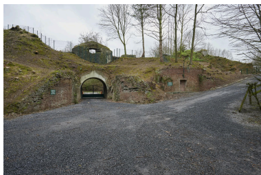
Depuis la rue du Rempart, passage couvert central menant jadis au casernes.
