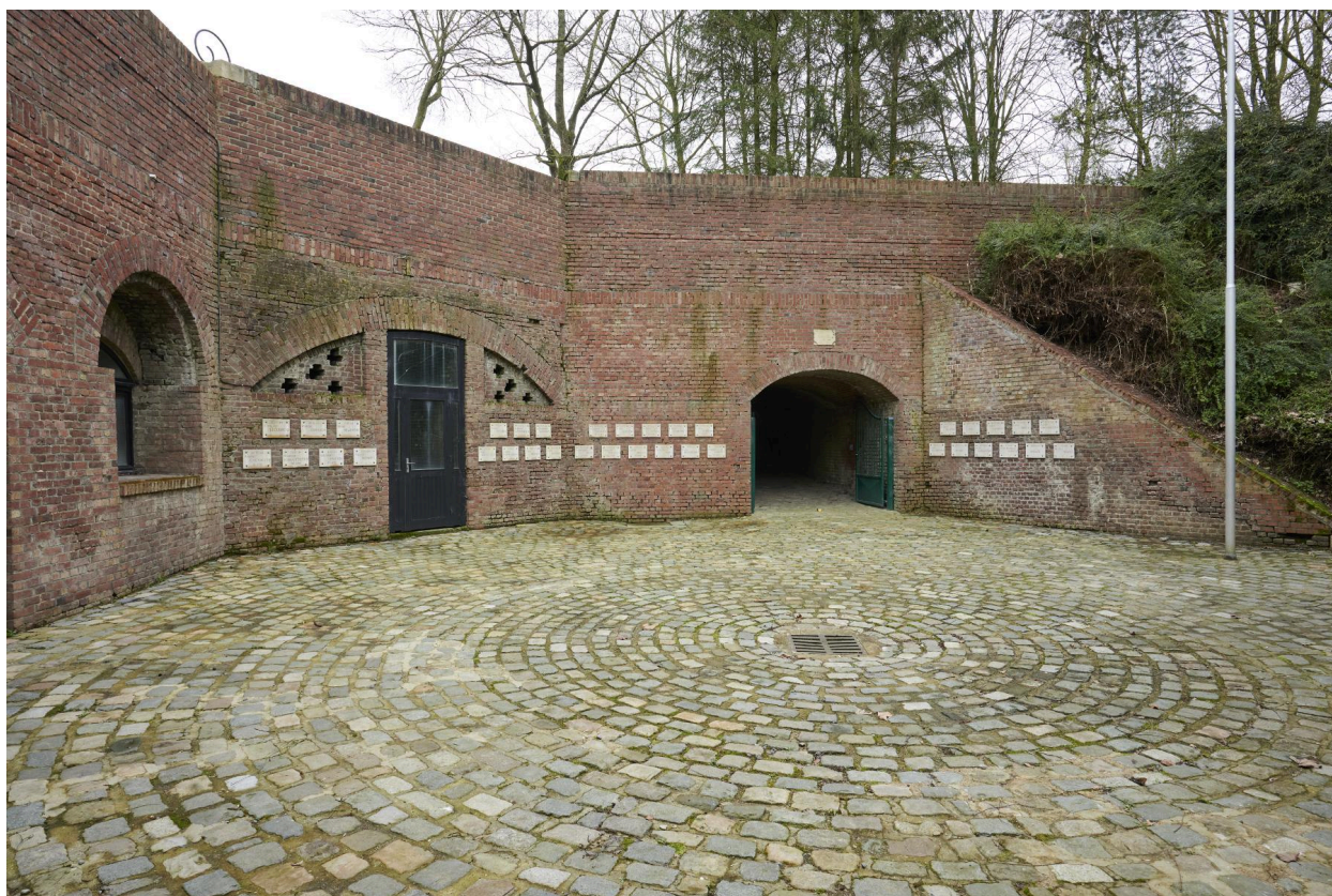
Latrines ouest. À droite, passage couvert menant à la cour centrale.
