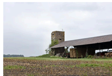
Vue générale, vers l'est Phot. Jean-Marc Ramette IVR31_20145904439NUCA
