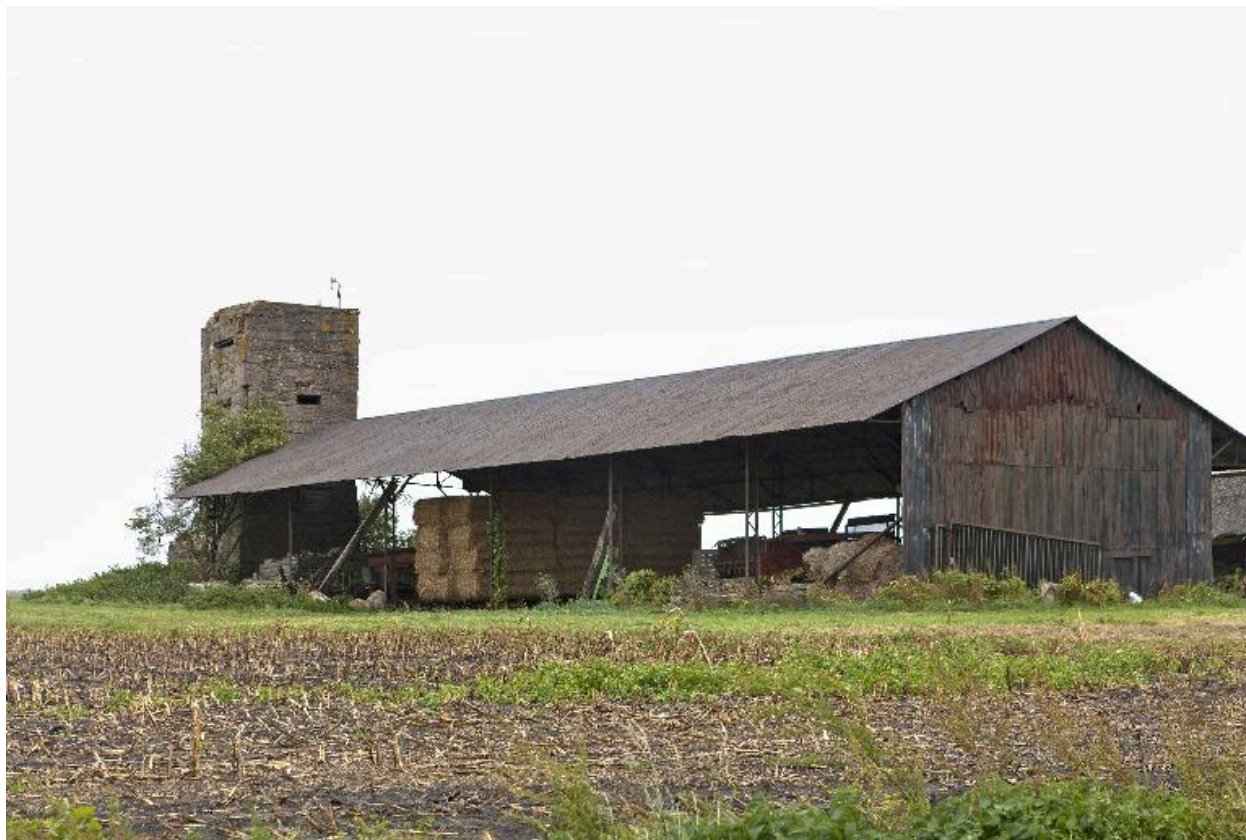
Vue générale, vers l'est
