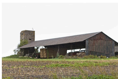
Vue générale, vers l'est Phot. Jean-Marc Ramette IVR31_20145904442NUCA
