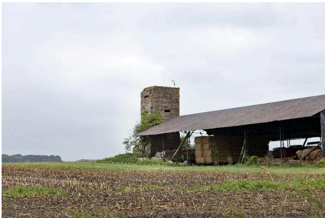
Vue générale, vers l'est
