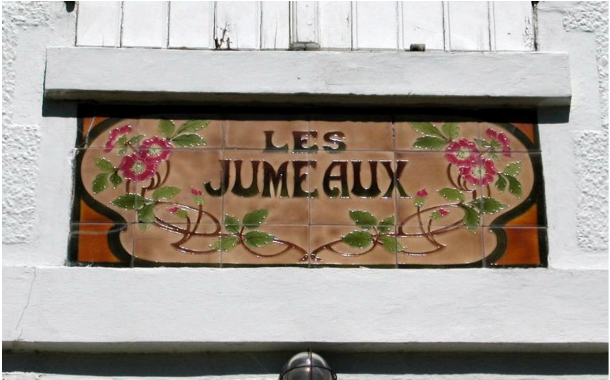
Détail des carreaux de céramique portant appellation Les Jumeaux.
