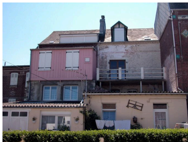
Vue d'ensemble sur la façade postérieure, côté mer. Phot. Elisabeth Justome IVR22_20048001469NUCA
