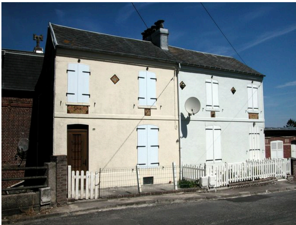
Vue d'ensemble depuis la rue Gros.
