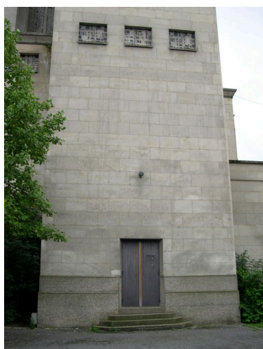
Vue de détail : base de la tour.
