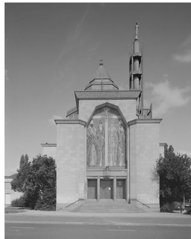
Élévation ouest. Phot. Thierry Lefébure IVR22_19968000274V
