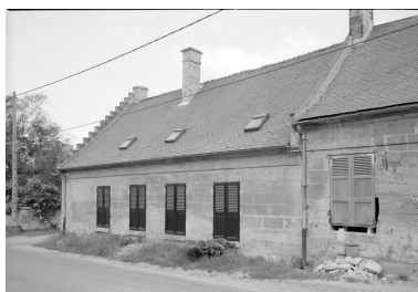
Logis. Elévation sur rue. Phot. Jean-Michel Perrin IVR22_19856000787X
