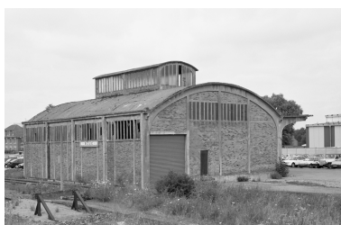
Vue du poste de chargement, depuis l'emplacement des voies. Phot. Thierry Lefébure IVR22_19960200593X
