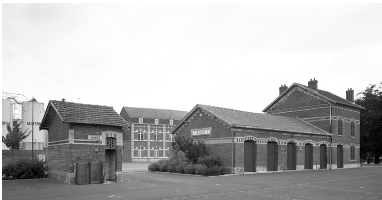
Vue générale, depuis le sud-ouest.
