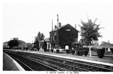
Actuelle gare de Boué vue depuis les voies, après 1922 (coll. part.). Phot. Thierry Lefébure IVR22_19950202991XB
