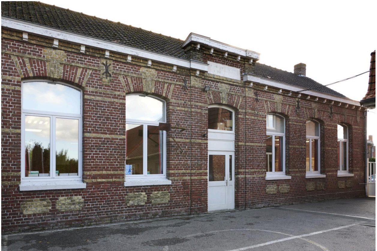
Façade sur cour du bâtiment sud-est.
