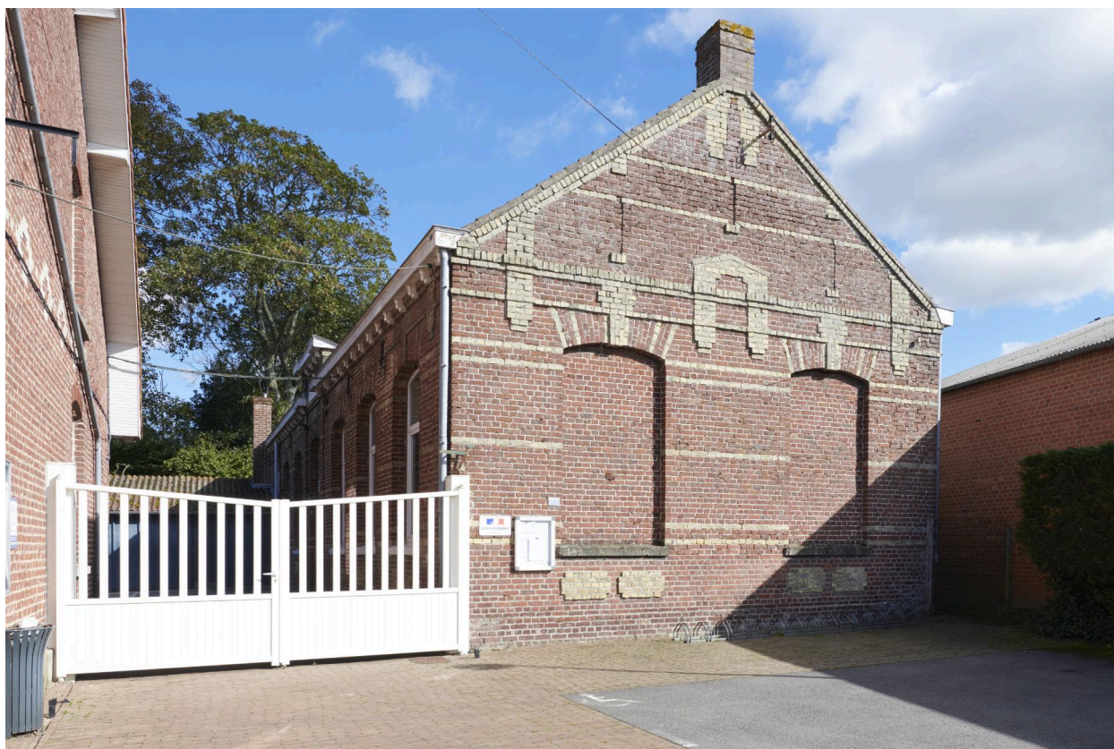
Bâtiment sud-est (ancienne école), pignon sur rue.
