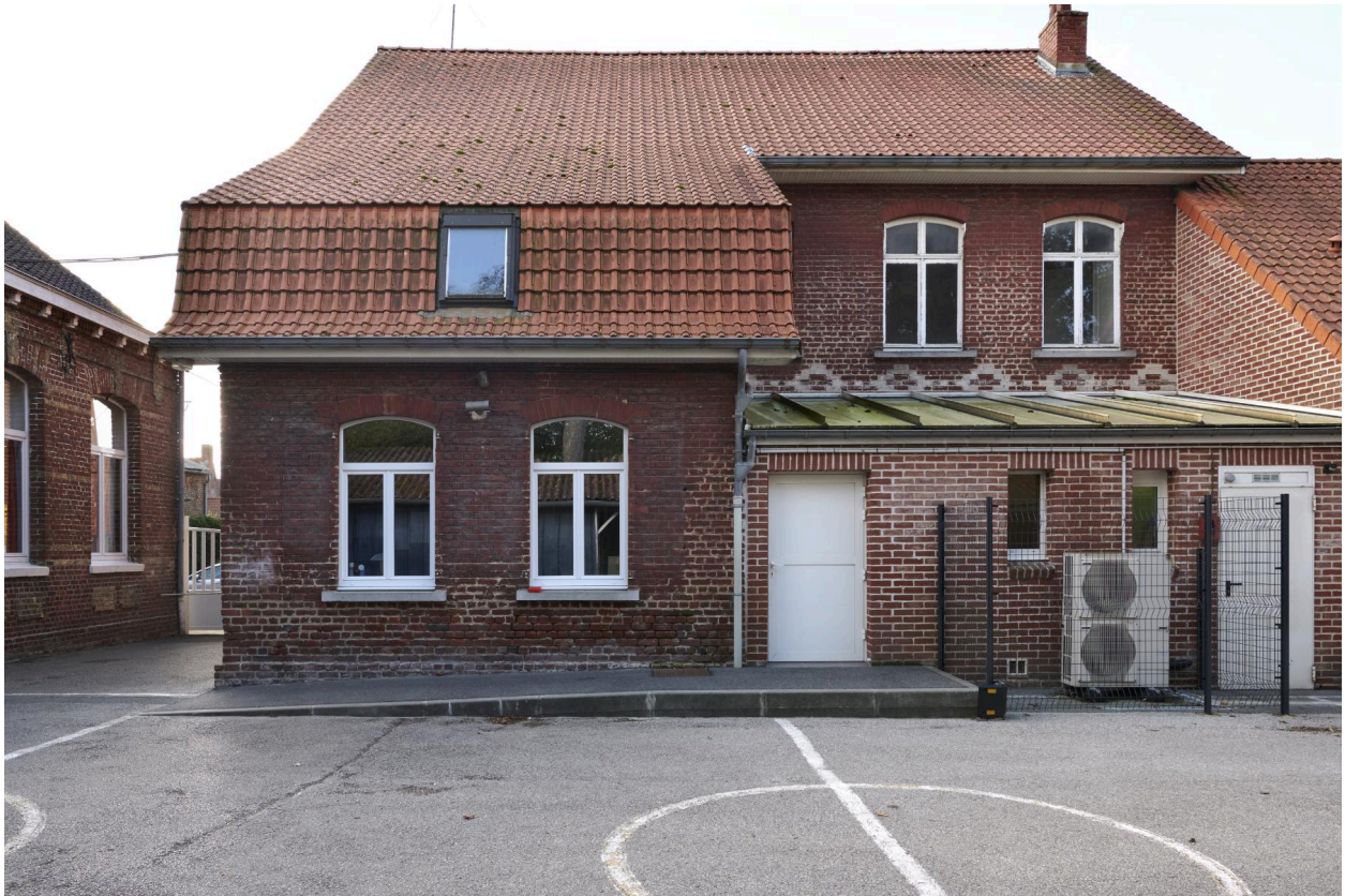
Arrière du bâtiment principal (ouest).
