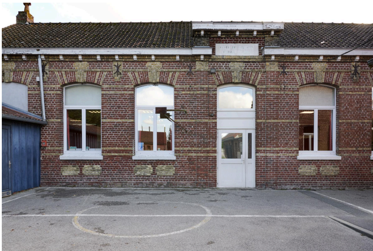
Détail de la façade sur cour du bâtiment sud-est.
