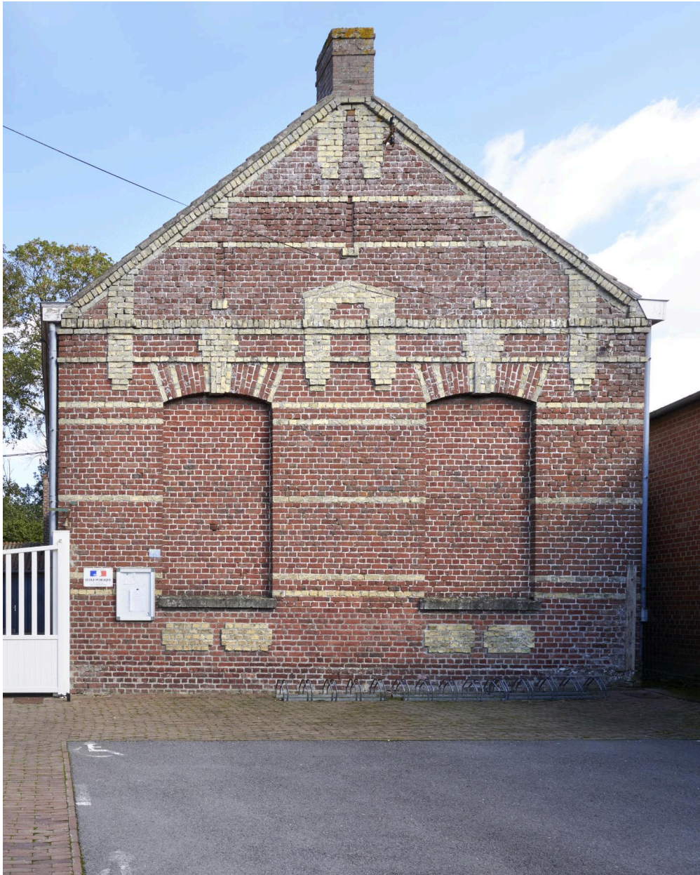
Pignon ouest du bâtiment secondaire.
