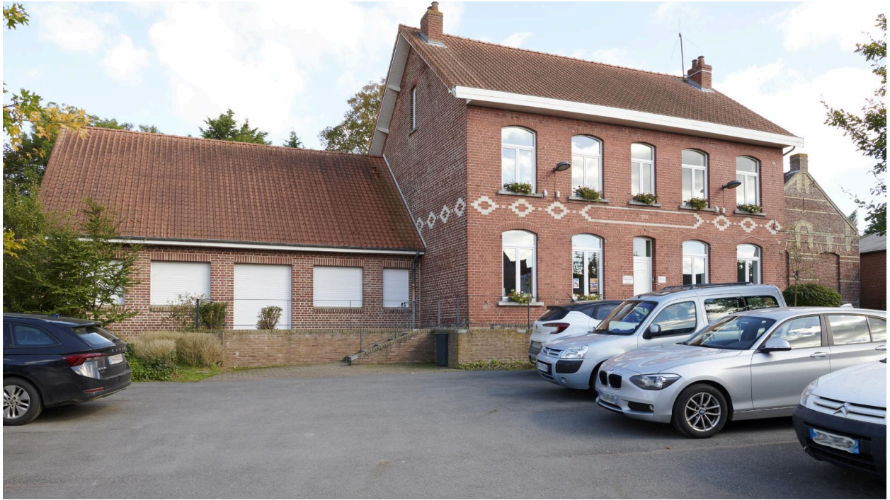
Bâtiment principal ouest, vue depuis le nord.
