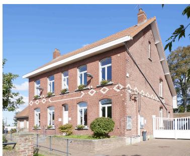
Façade avant du bâtiment principal ouest (ancienne mairie). Phot. Delphine Volto Jourdan IVR32_20255900641NUCA
