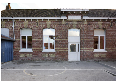
Détail de la façade sur cour du bâtiment sud-est. Phot. Delphine Volto Jourdan IVR32_20255900644NUCA
