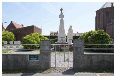
Le monument aux morts et son enclos. Phot. Delphine Volto Jourdan IVR32_20245902811NUCA
