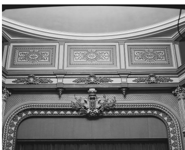
Ouverture de scène, partie supérieure. Phot. Philippe Dapvril IVR31_19946200226X
