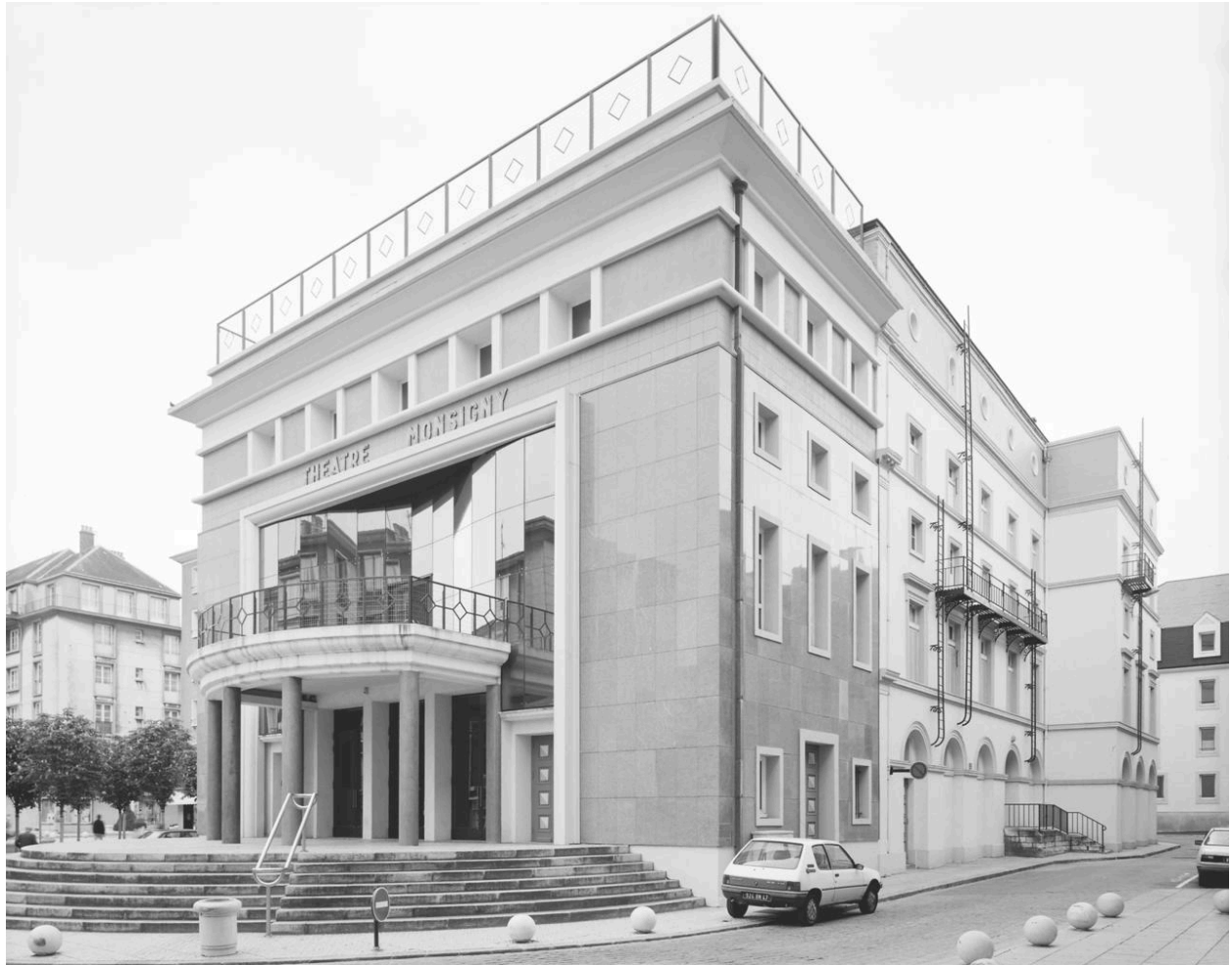
Vue d' angle sud.
