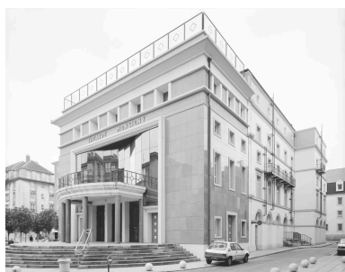
Vue d'angle sud.
