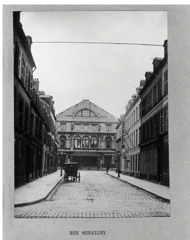
Façade d'entrée rue Monsigny vers 1900. A.C. Boulogne-sur-Mer, clichés vers 1900. Repro. Éric Dessert IVR31_19806202080XB
