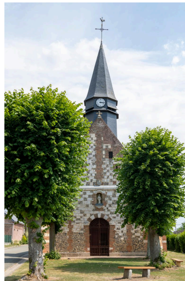
Vue depuis le nord-ouest. Phot. Marc Kérignard IVR32_20226000580NUCA
