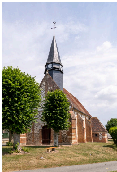
Vue depuis l'ouest. Phot. Marc Kérignard IVR32_20226000581NUCA
