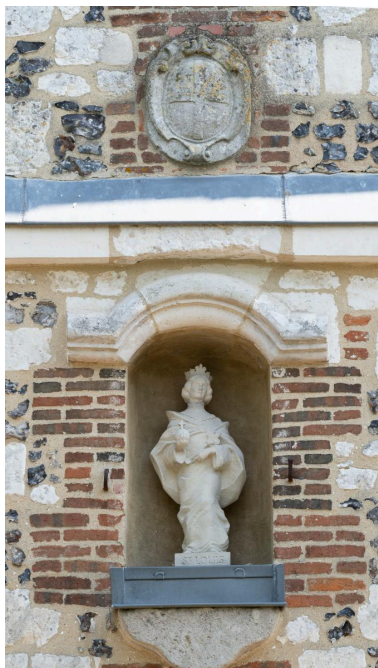
Façade occidentale : niche avec statue de saint Louis surmontée d'une croix en médaillon. Phot. Marc Kérignard IVR32_20226000583NUCA
