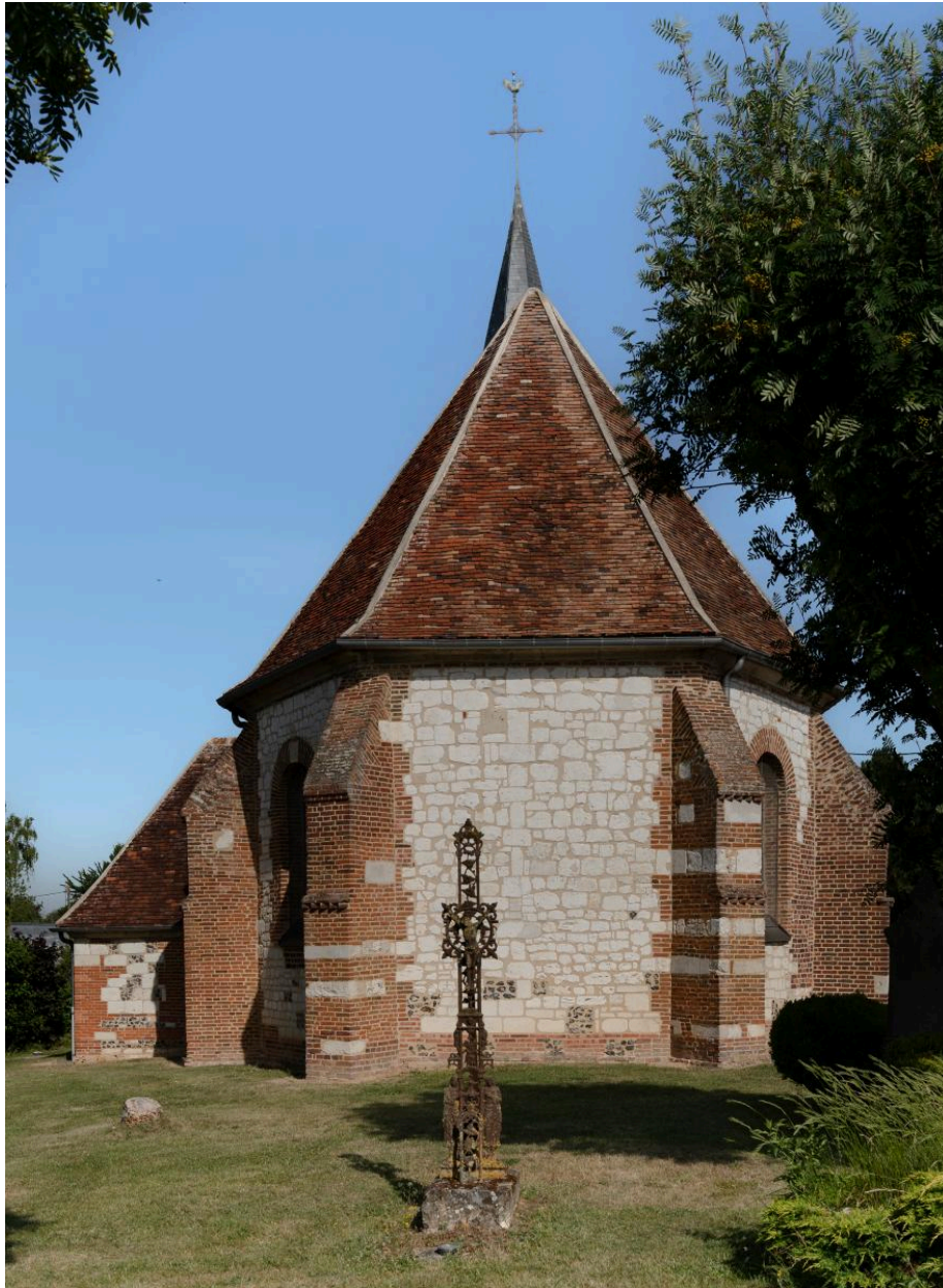
Vue du chevet depuis le sud-est.
