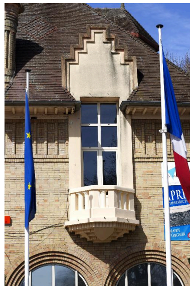
Détail d'un balcon. Phot. Thierry Lefébure IVR32_20170200109NUC2A
