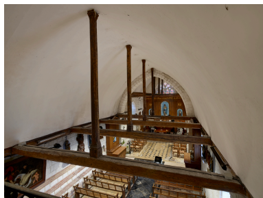
Intérieur, vue de la charpente et la fausse voûte depuis la tribune. Phot. Thierry Lefébure IVR32_20258000058NUCA
