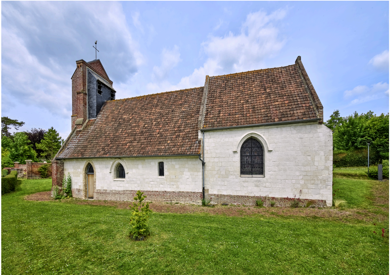
Vue de la façade sud.
