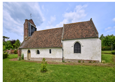
Vue de la façade sud. Phot. Thierry Lefébure IVR32_20258000054NUCA
