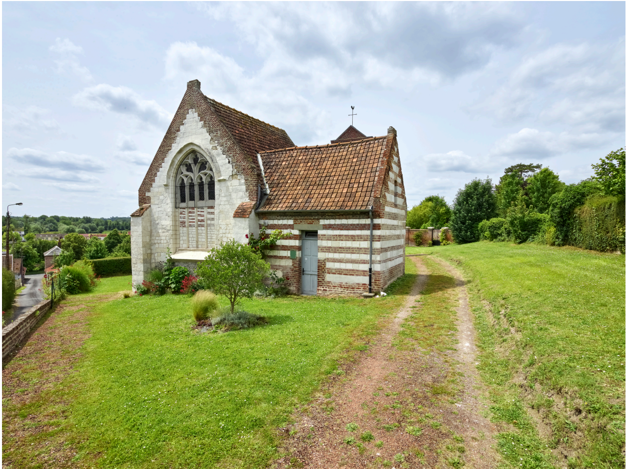
Vue du chevet et de la sacristie, depuis l'est.
