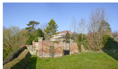
Enclos de l'ancien cimetière, à l'ouest de l'église. Phot. Thierry Lefébure IVR32_20258000105NUCA
