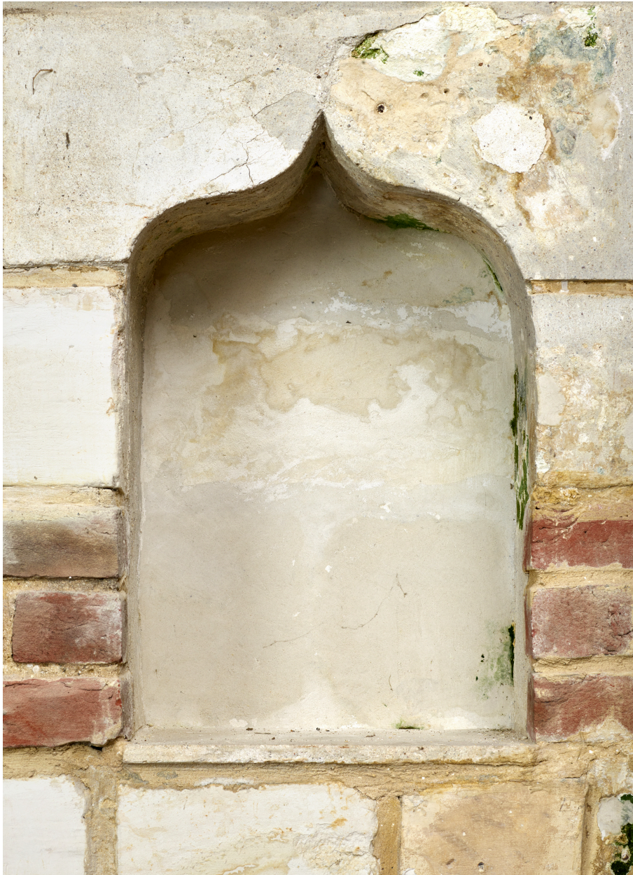
Intérieur, niche aménagée dans le mur nord de la nef.
