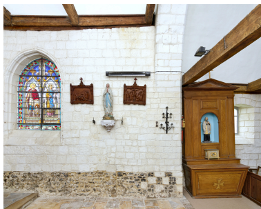
Intérieur, détail de la maçonnerie du mur sud du chœur. Phot. Thierry Lefébure IVR32_20258000081NUCA
