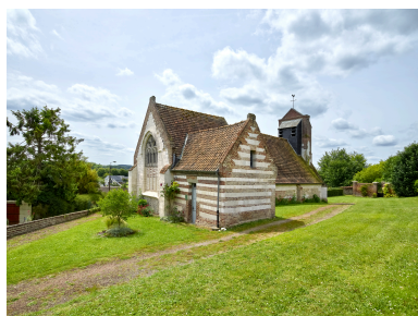
Vue d'ensemble de l'église, depuis le nord-est. Phot. Thierry Lefébure IVR32_20258000053NUCA
