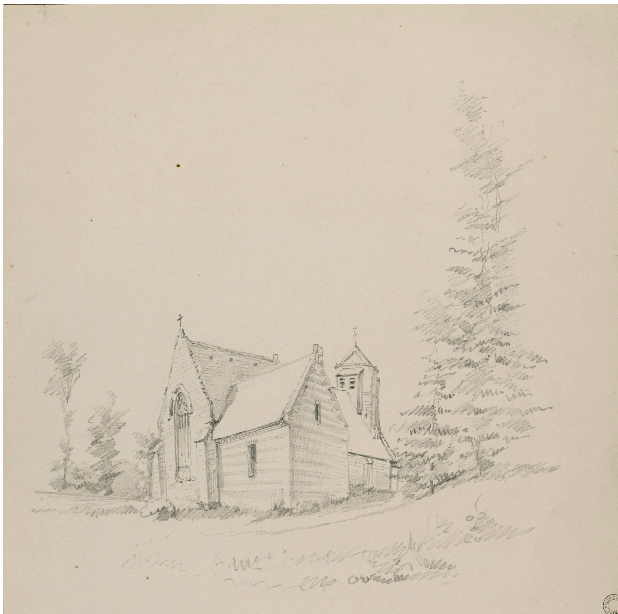
Église de Grand-Laviers (canton nord d'Abbeville), par L. Gillard, 1844 ou 1864 (Archives et Bibliothèque patrimoniale d'Abbeville ; Ab. N58).
