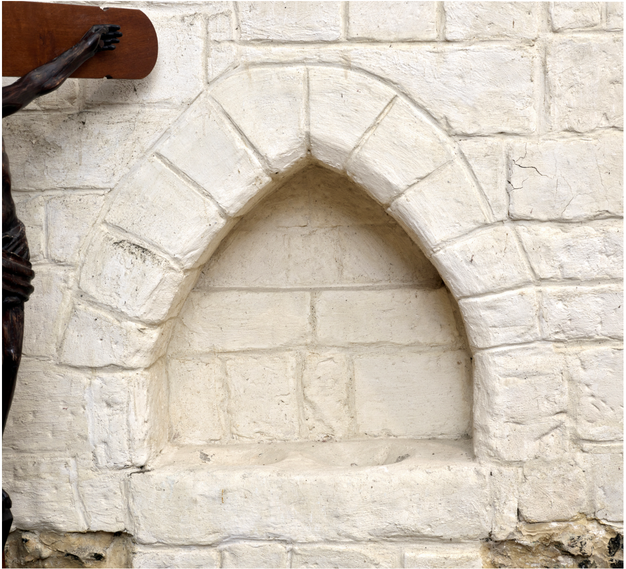
Intérieur, niche lavabo aménagée sur le mur sud du chœur.
