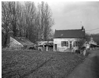
Vue d'ensemble sud-ouest de la maison et de ses annexes.
