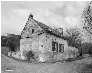
Vue d'ensemble de la maison, depuis l'est.
