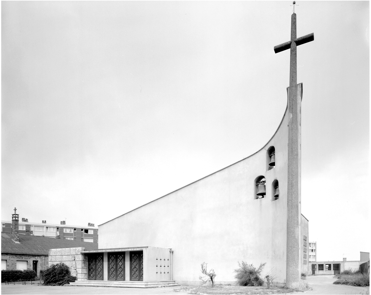
Façade sud-est, sur voie.
