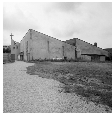
Angle nord. Phot. Philippe Dapvril IVR31_19896200722X
