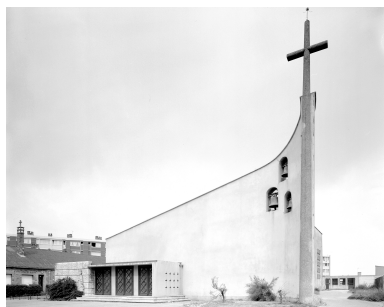
Façade sud-est, sur voie. Phot. Philippe Dapvril IVR31_19896200709V
