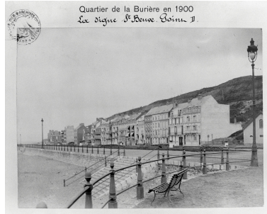
Vue d'ensemble en 1900, cliché A.C. Boulogne-sur-Mer, clichés 1900. Repro. Éric Dessert IVR31_19806202245XB
