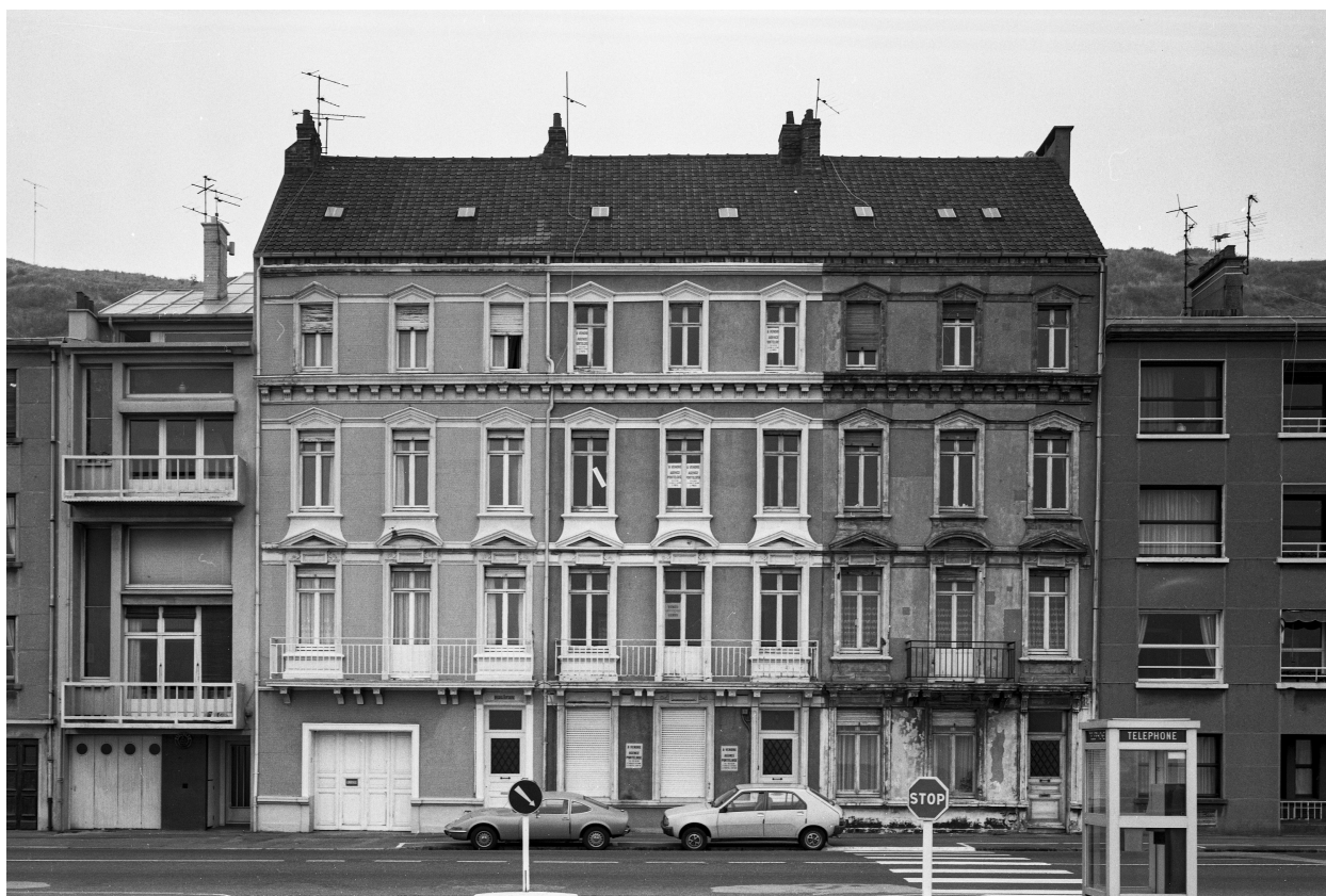
Vue d'ensemble sur voie.
