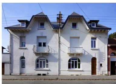
Vue générale. Phot. Hubert Bouvet IVR32_20196200669NUC4A
