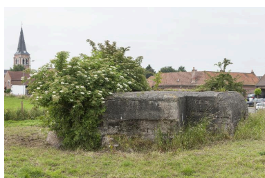
Casemate a, vers le sud-ouest Phot. Jean-Marc Ramette IVR31_20145905594NUCA
