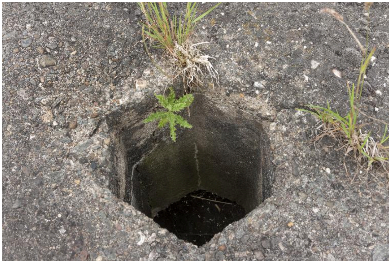
Casemate b. Cheminée du périscope sur le couverture
