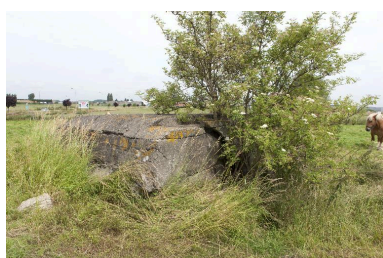
Casemate b, vue de trois-quarts vers le nord-ouest. Phot. Jean-Marc Ramette IVR31_20145905598NUCA
