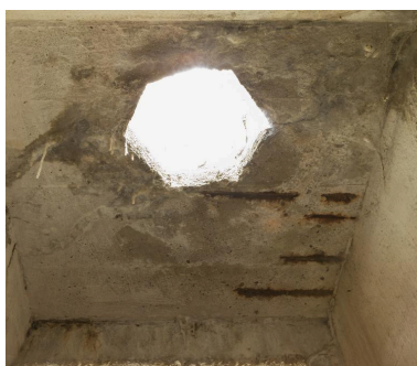
Casemate b. Vue intérieure de l'observatoire bétonné. Passage du périscopes. Phot. Jean-Marc Ramette IVR31_20145905602NUCA
