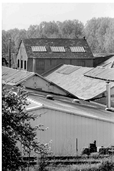
Anciens ateliers. Vue des toitures.
