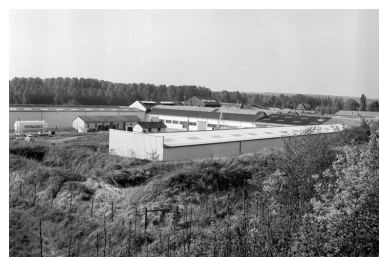
Anciens ateliers, vue partielle, flanc sud. Phot. Benoît Dufournier IVR22_19888000647Z
