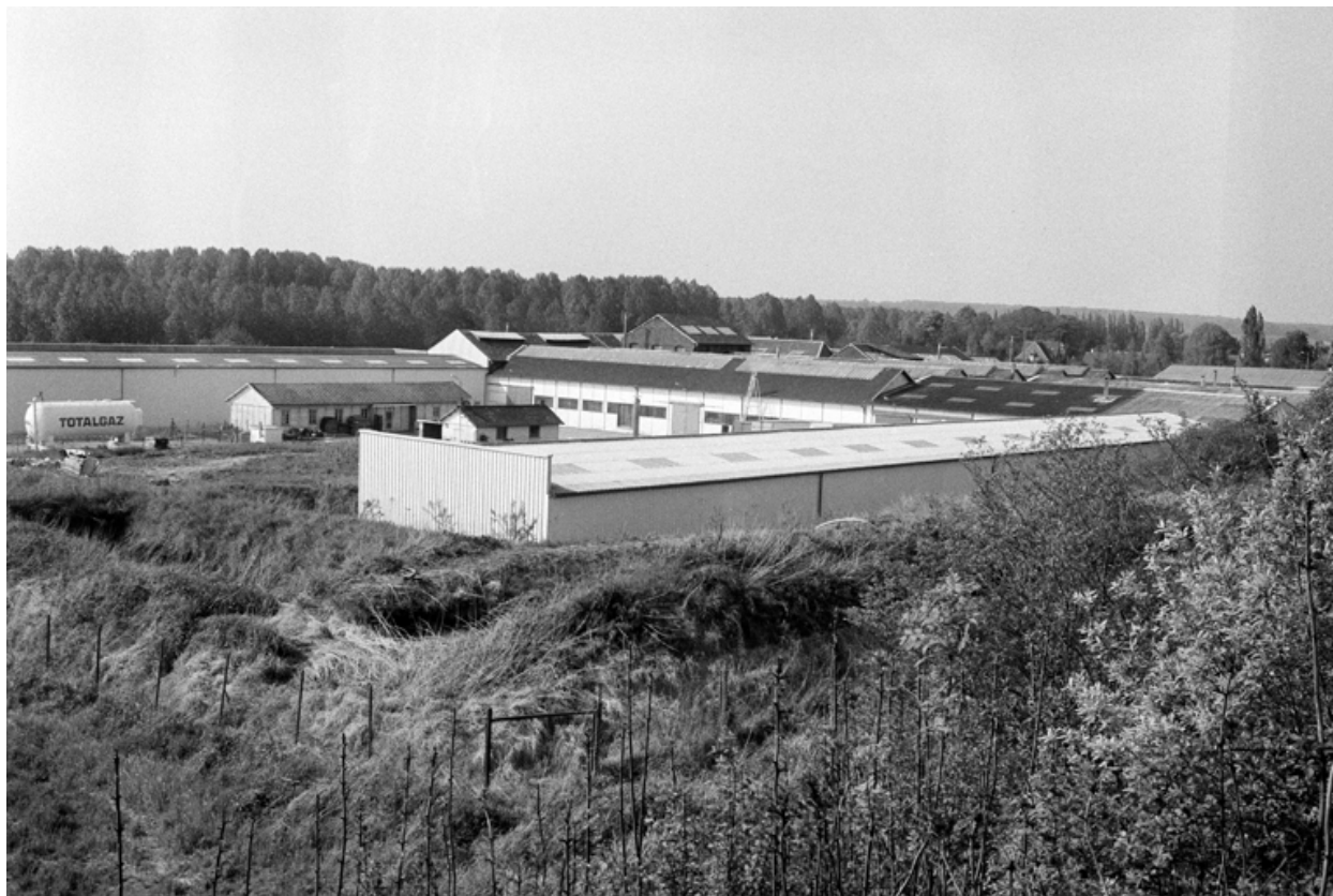
Anciens ateliers, vue partielle, flanc sud.
