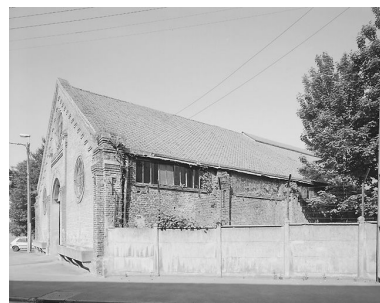
Vue latérale, façade nord-est. Phot. Pierre Thibaut IVR31_20015901181V
