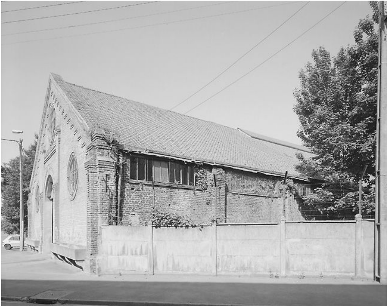
Vue latérale, façade nord-est.
