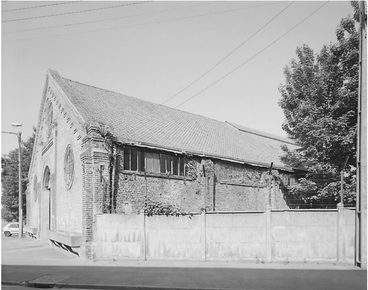
Vue latérale, façade nord-est.
