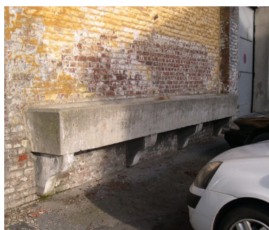
Façade, détail : abreuvoir à chevaux. Phot. Anita Oger-Leurent IVR31_20065906231NUCA
