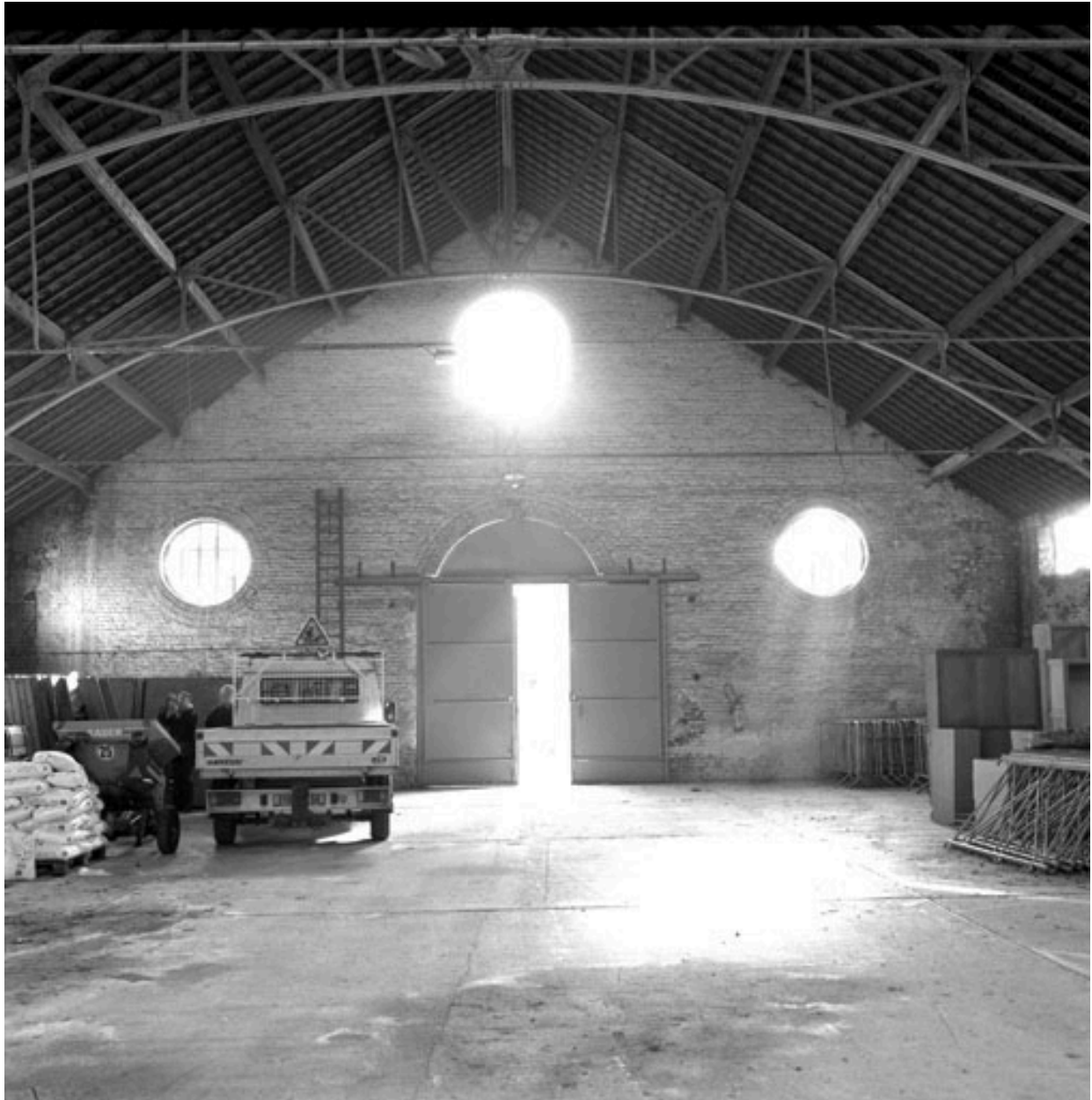
Intérieur : vue générale vers le sud-est.
