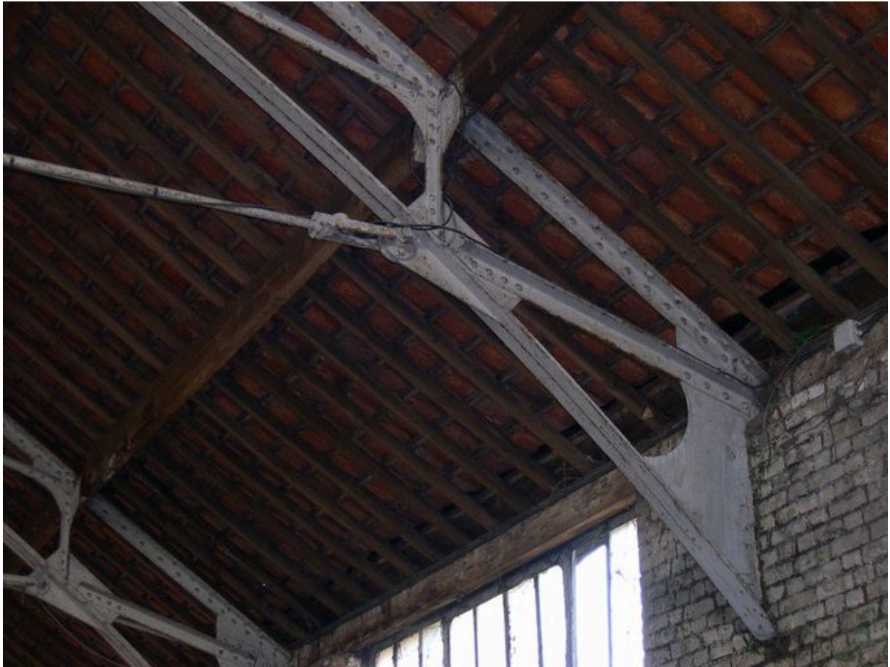
Intérieur : ferme métallique, détail.
