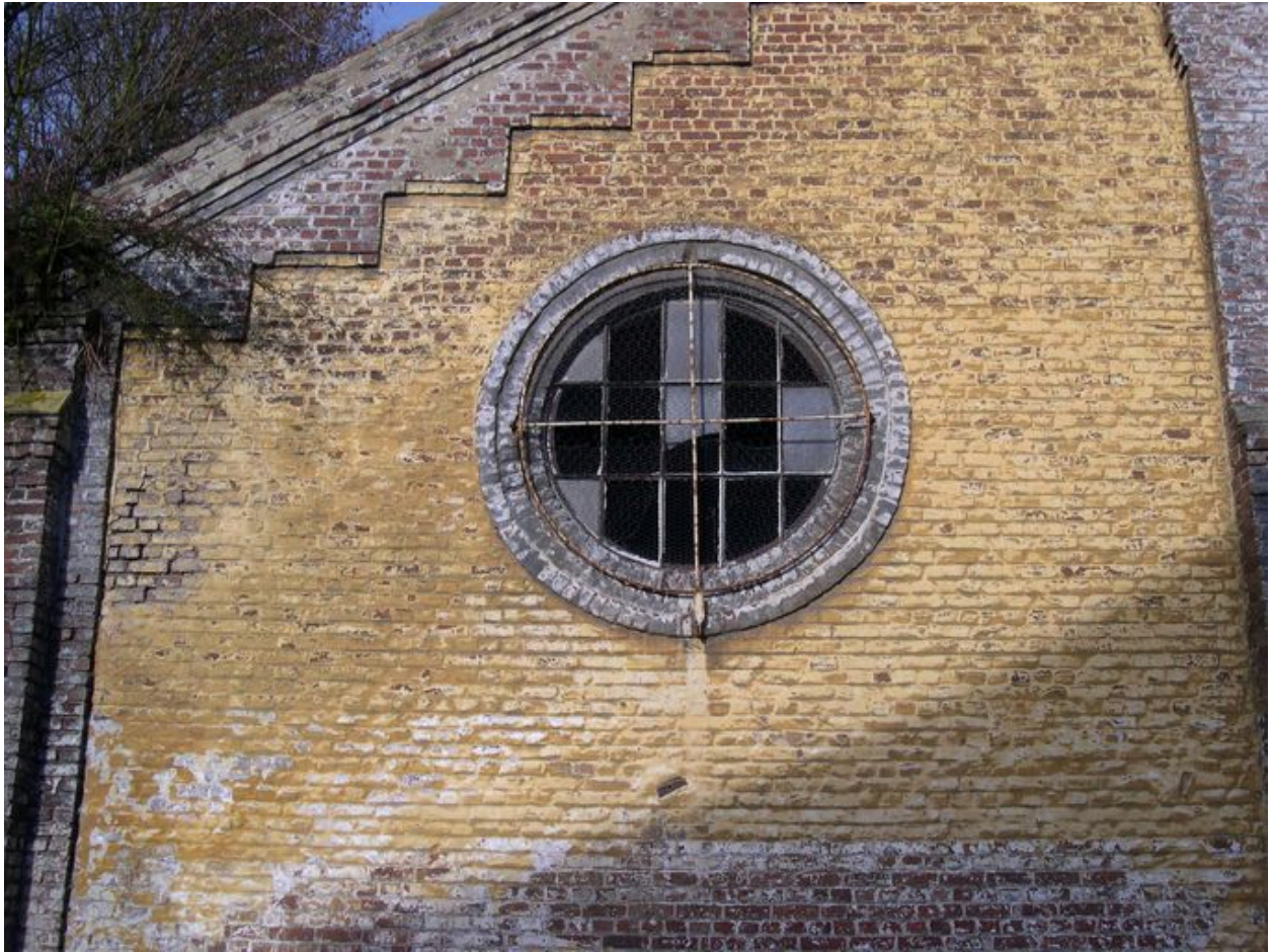
Façade, vue partielle : reliefs de briques et badigeon.
