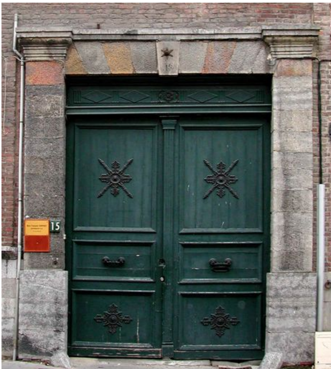
Façade, détail : porte cochère.
