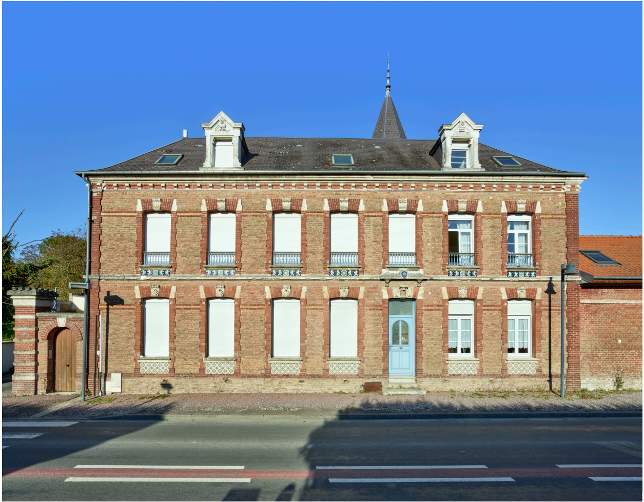
Vue de l'élévation sud, depuis la rue.
