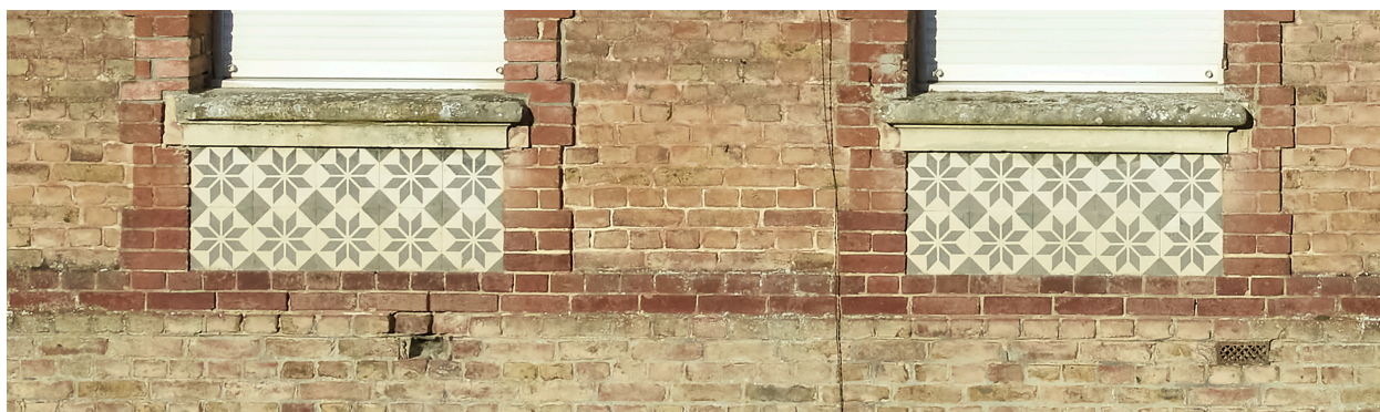
Détail des céramiques sous les assises des fenêtres.
