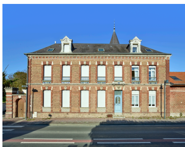
Vue de l'élévation sud, depuis la rue.
