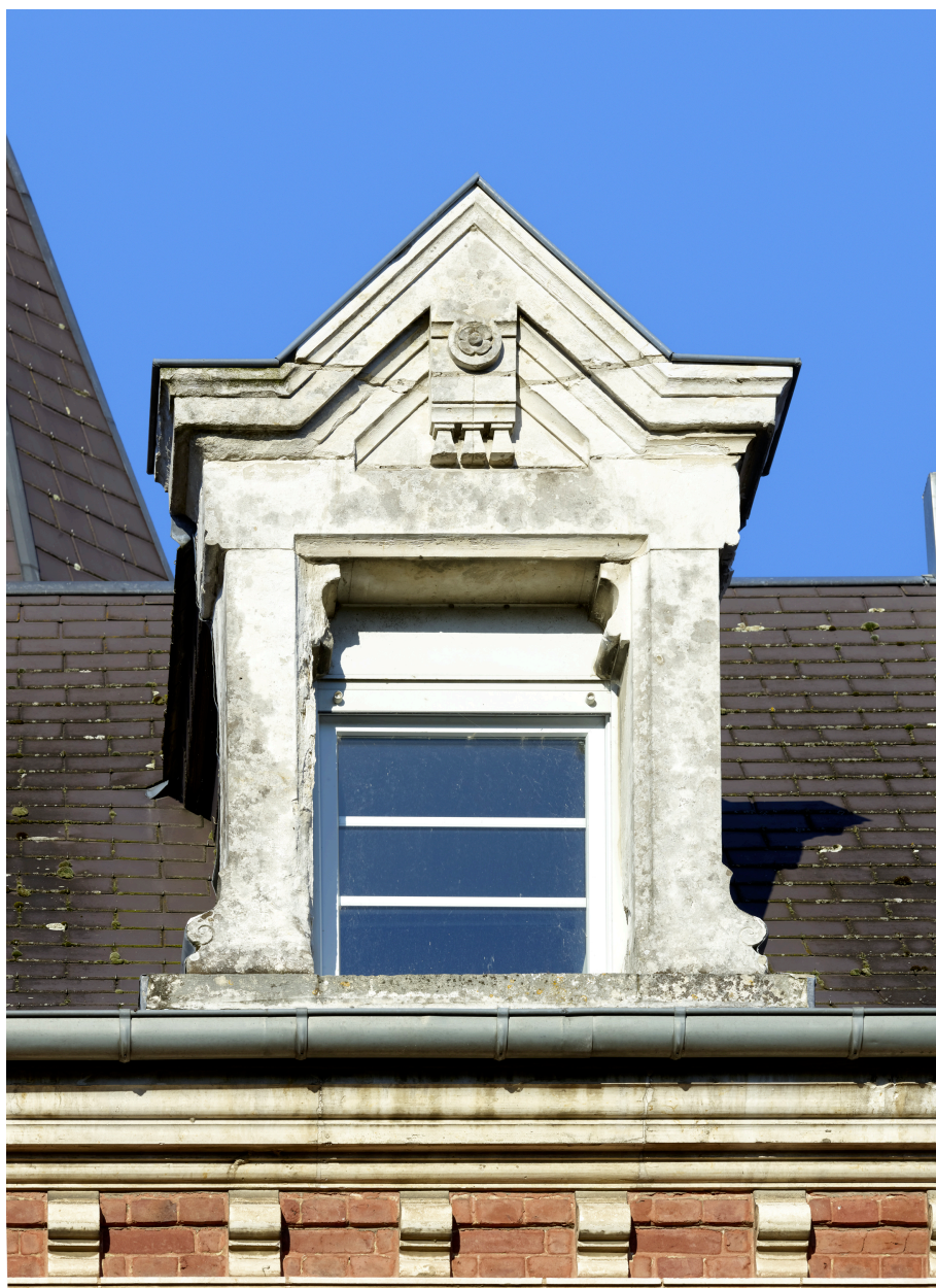
Détail d'une des lucarnes.
