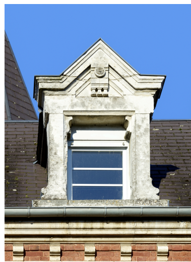
Détail d'une des lucarnes.
