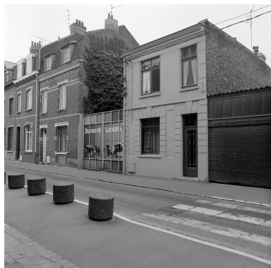
Élévation antérieure, rue Jean-Macé.
