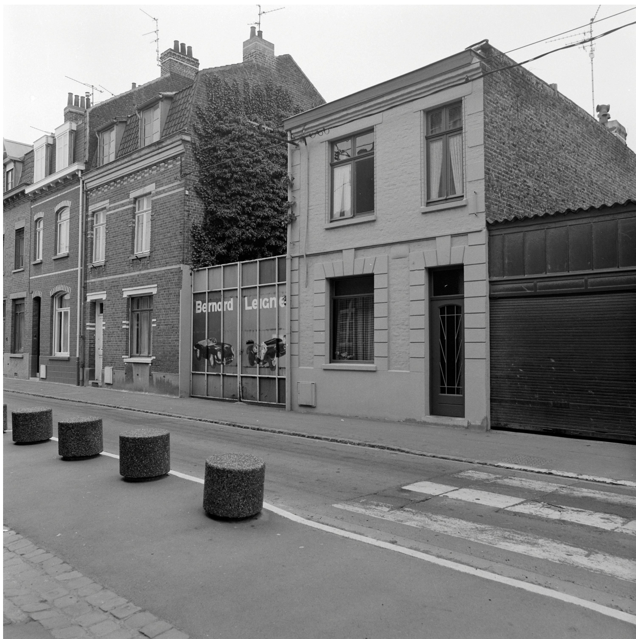
Élévation antérieure, rue Jean-Macé.
