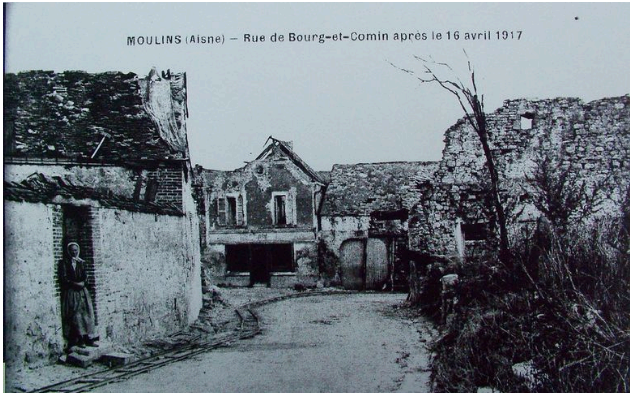
Vue de la rue de Bourg-et-Comin en ruines (coll. part).
