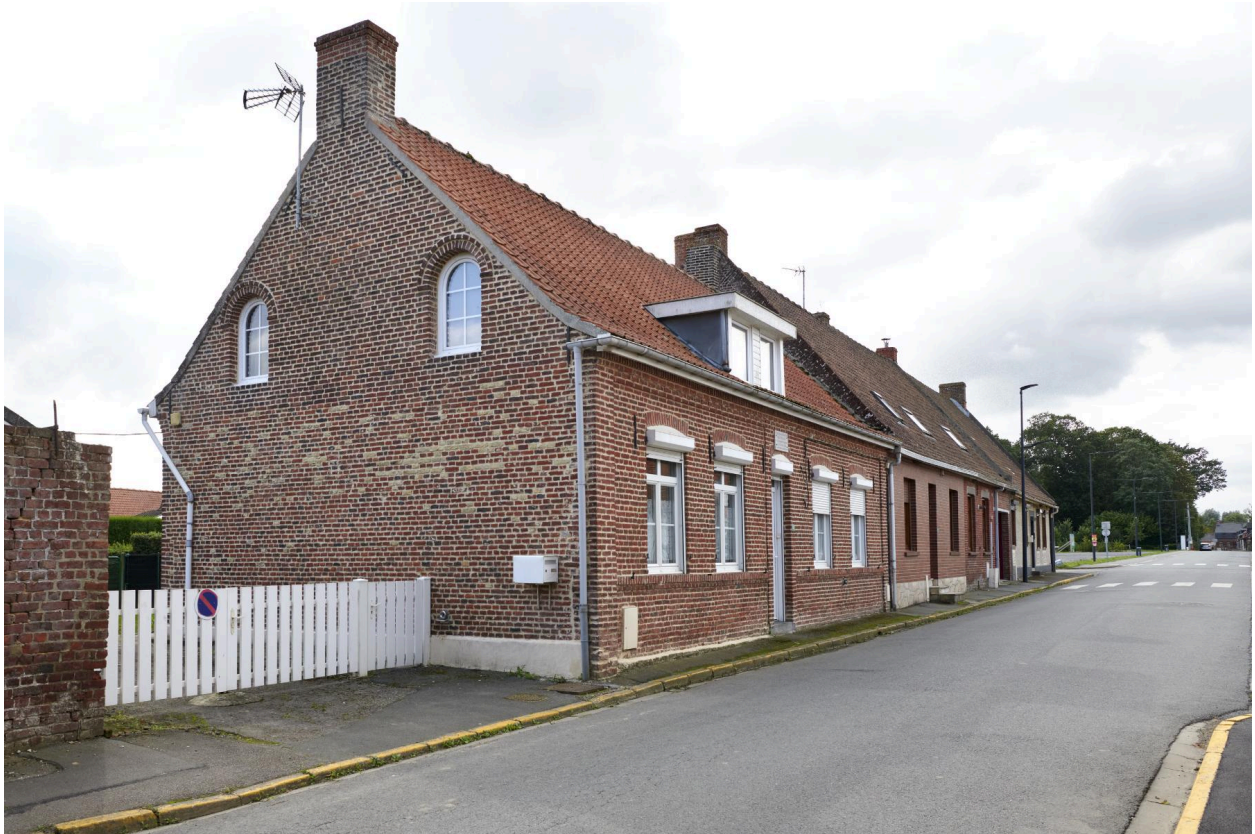
Façade et pignon est.
