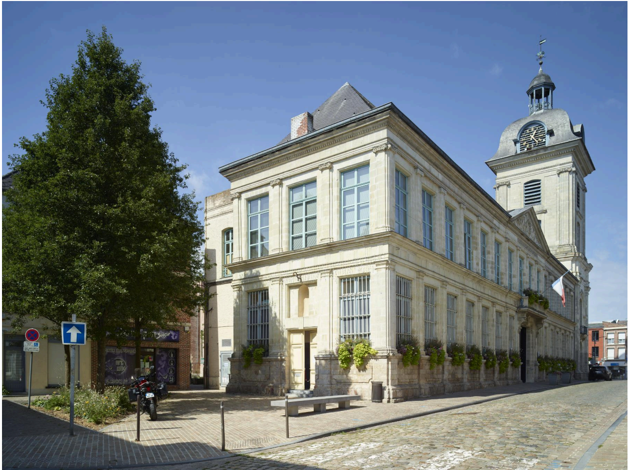
Hôtel de ville et beffroi depuis la rue du Maréchal-Joffre. Vue orientée nord-ouest/sud-est.
