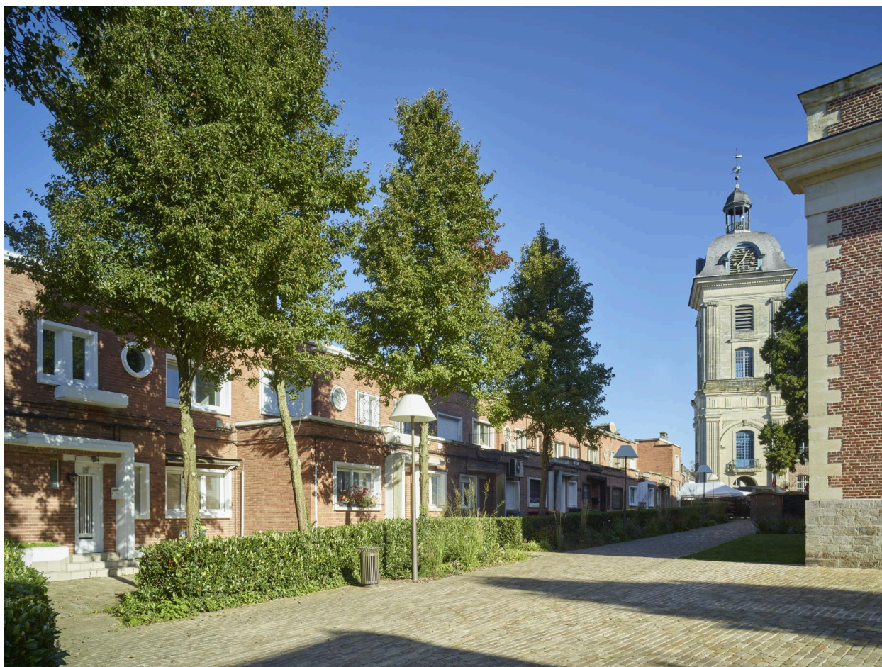
Vue du beffroi depuis le parvis de l'église. Vue orientée nord-est/sud-ouest.
