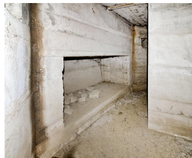
Passage de la salle nord à la salle sud. A gauche le mur de refend, à droite une niche Phot. Jean-Marc Ramette IVR31_20145905053NUCA
