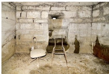
Salle sud, vers l'ouest Phot. Jean-Marc Ramette IVR31_20145905055NUCA
