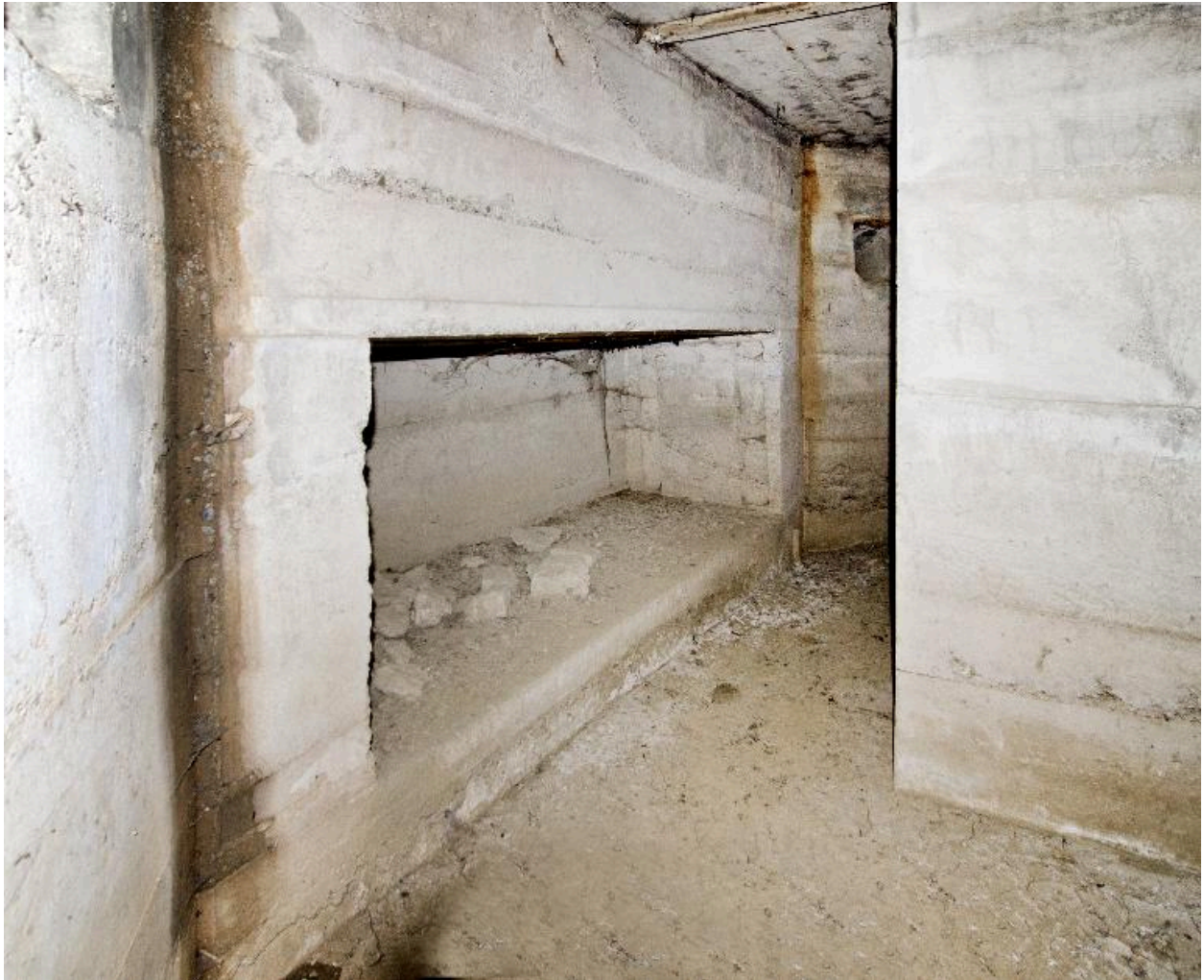
Passage de la salle nord à la salle sud. A gauche le mur de refend, à droite une niche
