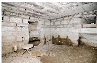
Salle nord, vers le nord-ouest. Niches et créneaux de fusillade Phot. Jean-Marc Ramette IVR31_20145905050NUCA
