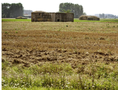
Vue générale vers sud ouest. En arrière plan, deux autres casemates à mitrailleuse (IA59004921 et IA59004903) Phot. Jean-Marc Ramette IVR31_20145905063NUCA
