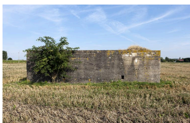
Élévation ouest (face au front) Phot. Jean-Marc Ramette IVR31_20145905066NUCA
