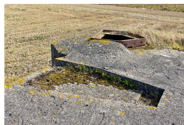
Depuis le couvrement, vers le sud. La cuve à mitrailleuse et l'observatoire cuirassé Phot. Jean-Marc Ramette IVR31_20145905070NUCA
