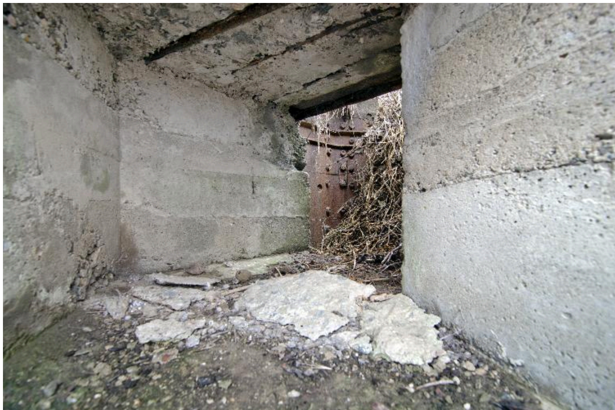
Conduit menant à l'observatoire cuirassé.
