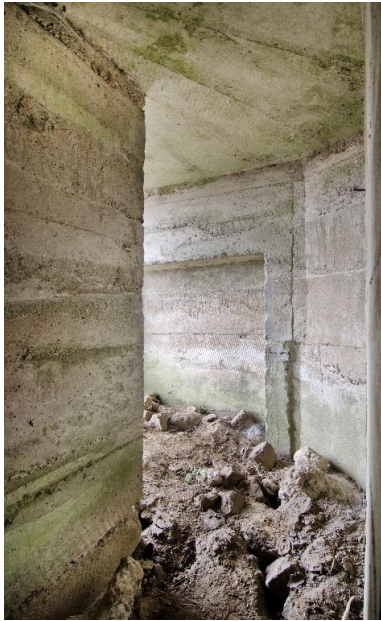
Sortie nord, chicane vers l'extérieur Phot. Jean-Marc Ramette IVR31_20145905056NUCA
