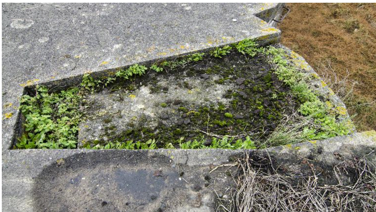
Depuis le couvrement, vers le nord. La cuve à mitrailleuse
