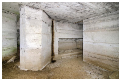
Salle nord avec, de gauche à droite, l'entrée en chicane, la niche centrale et le mur de refend (au grand angulaire) Phot. Jean-Marc Ramette IVR31_20145905051NUCA
