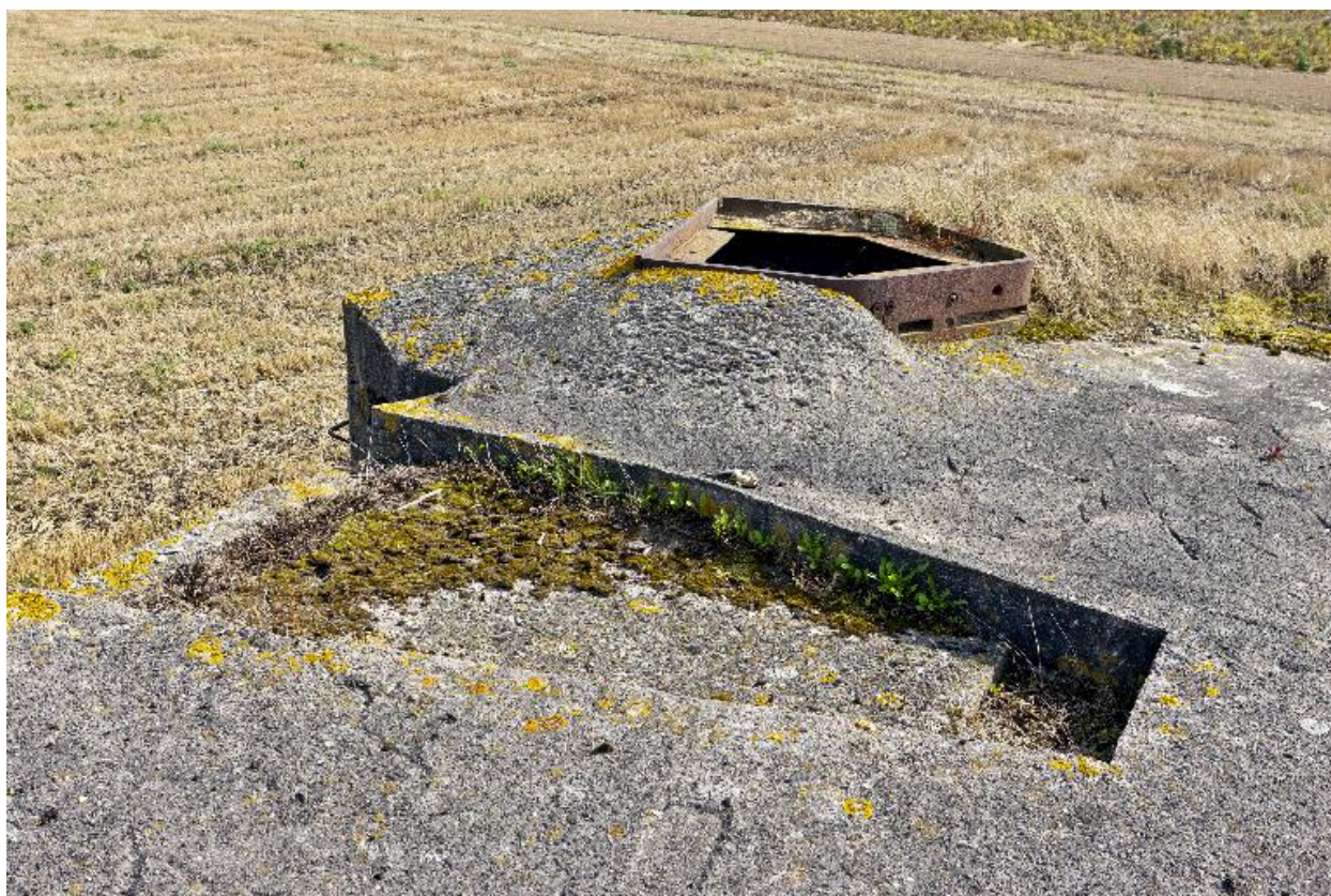
Depuis le couverture, vers le sud. La cuve à mitrailleuse et l'observatoire cuirassé
