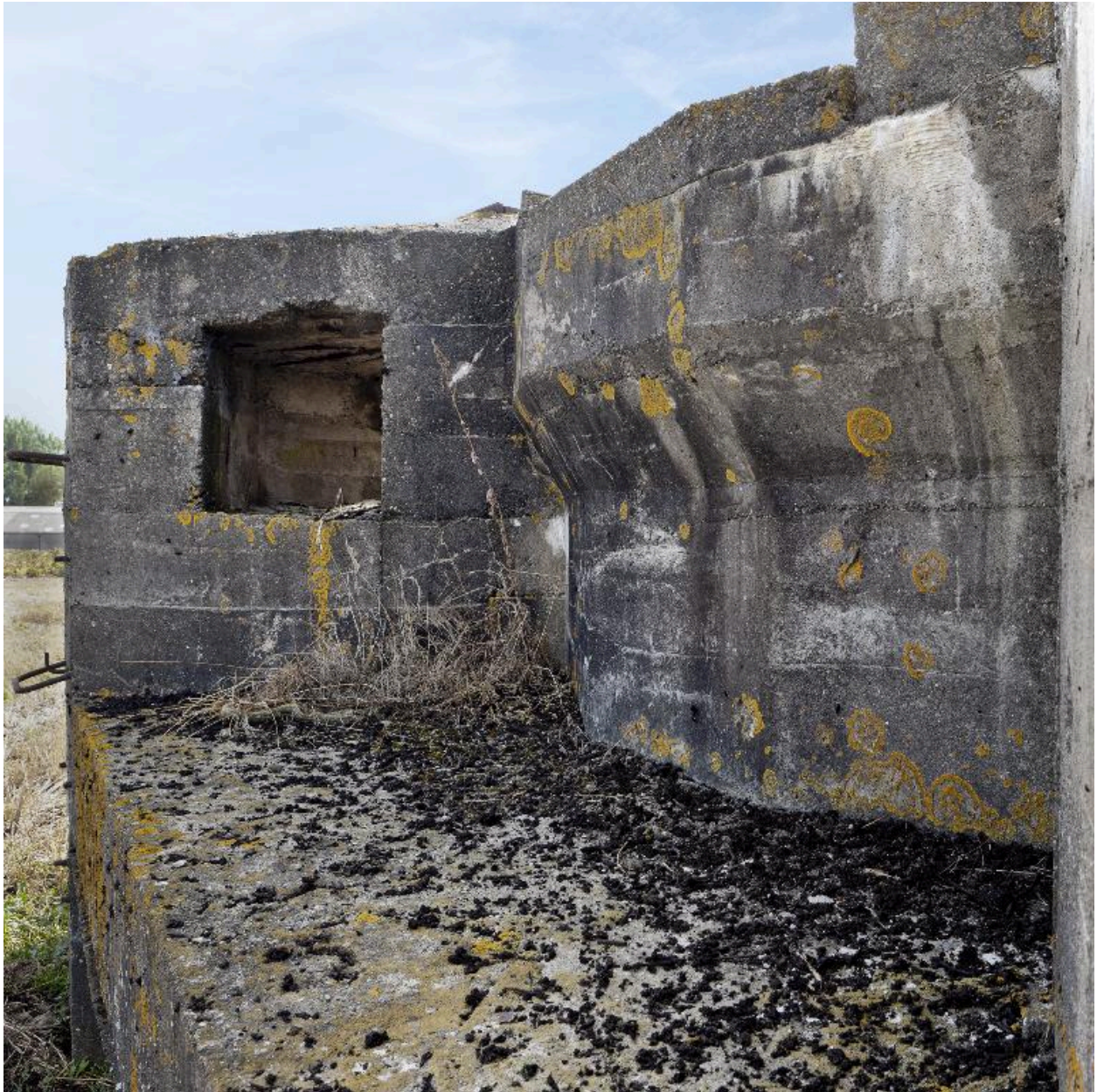
Depuis la banquette de tir, l'accès à l'observatoire cuirassé
