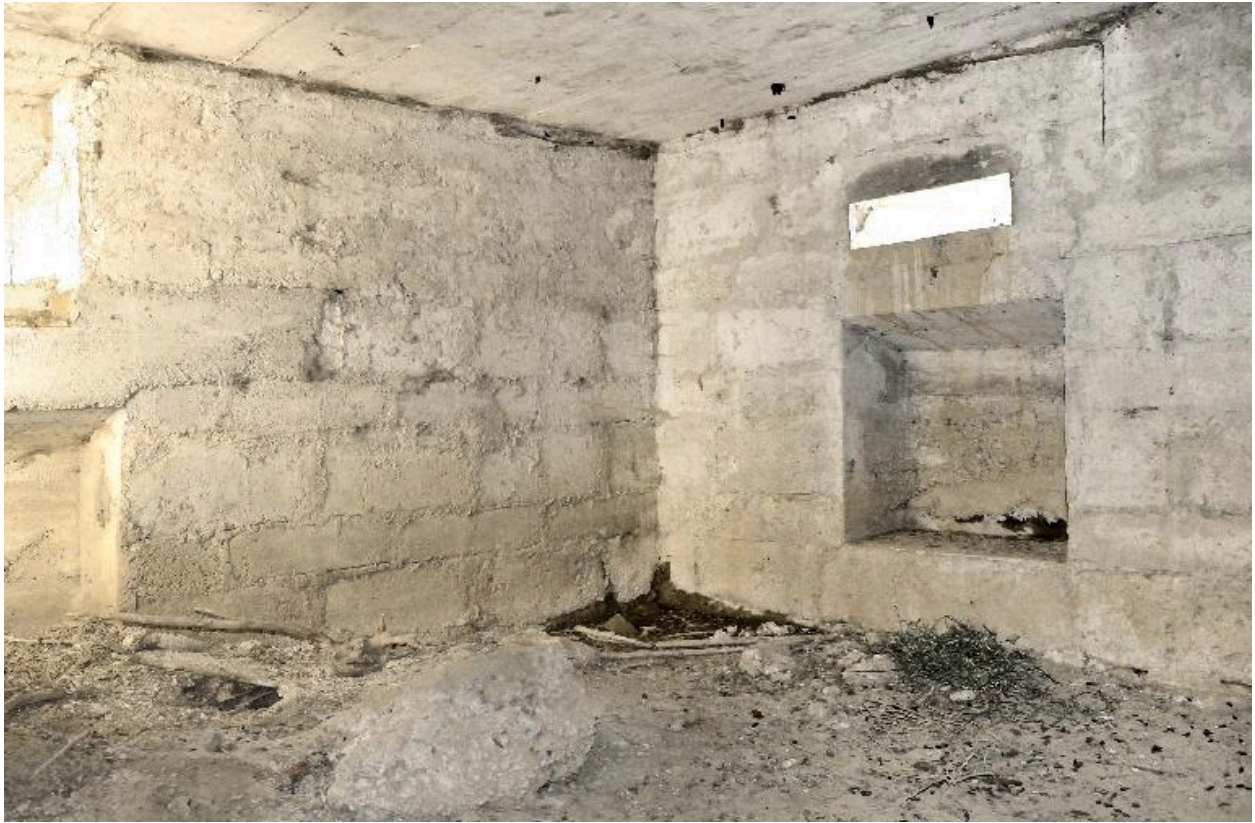
Angle sud-ouest de la salle sud (au grand angulaire)
