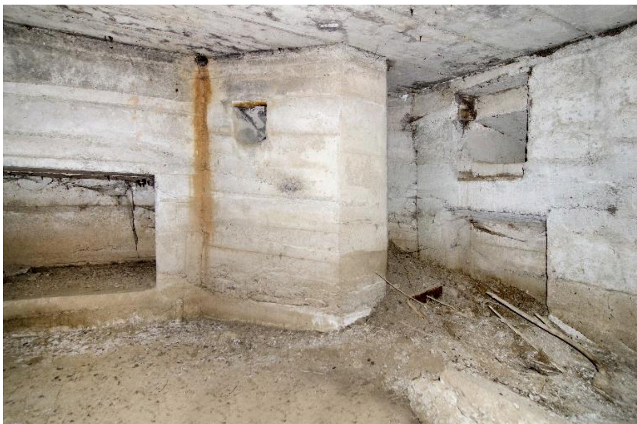
Salle sud avec, de gauche à droite, la niche centrale et l'entrée en chicane (au grand angulaire)
