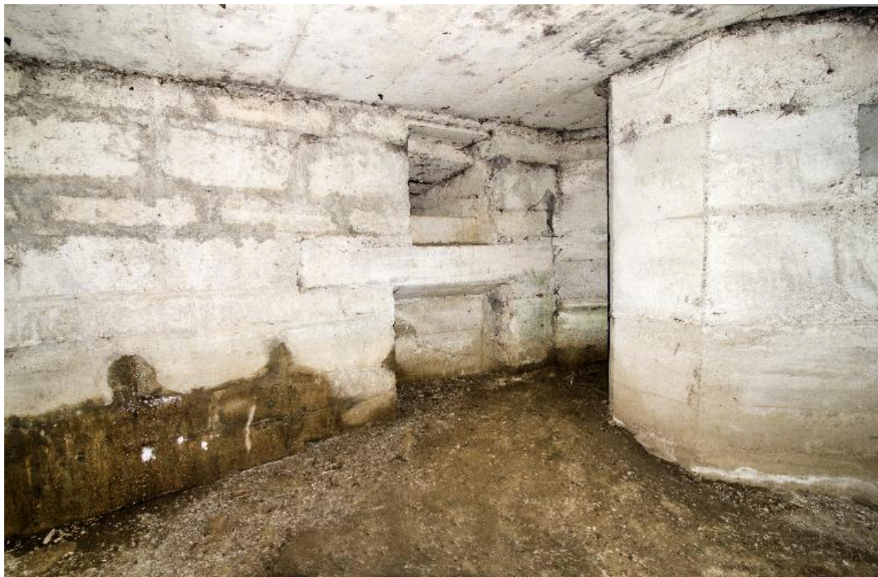
Salle nord vers le nord-est. Entrée du couloir en chicane et créneau de fusillade (au grand angulaire)
