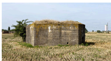
Élévation sud Phot. Jean-Marc Ramette IVR31_20145905062NUCA
