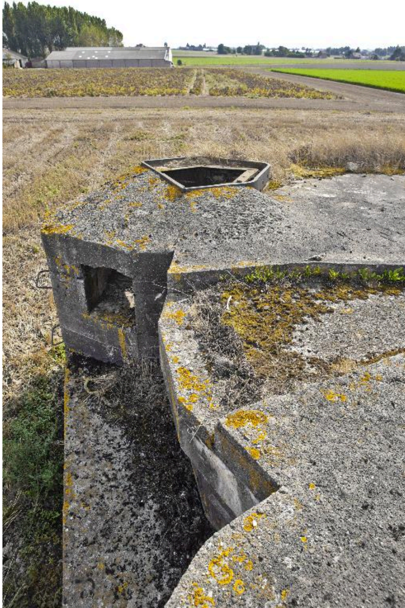
Depuis le couverture, vers le sud. La cuve à mitrailleuse et l'observatoire cuirassé
